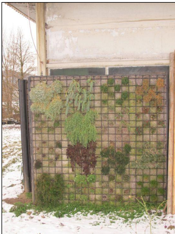
Foto 115: Stěna E (31.1-2014, autor: Petra Suldovská)
