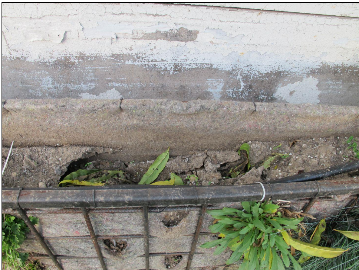
Foto 174: Propadající se zemina a odhalená kapková závlaha ( 12.11.2014, autor: Petra Suldovská)
