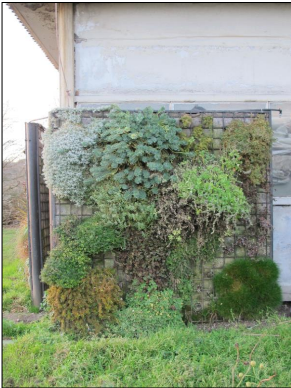
Foto 171: Stěna E (15.12.2014, autor: Petra Suldovská)
