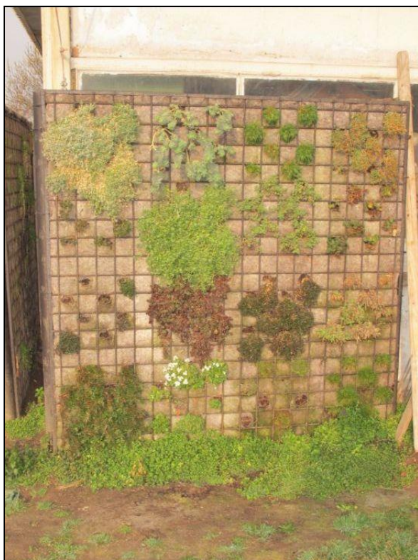
Foto 121: Stěna E ( 5.3.2014, autor:Petra Suldovská)
