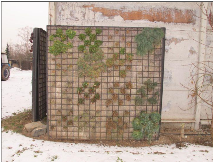
Foto 112: Stěna B (31.1.2014, autor: Petra Suldovská)
