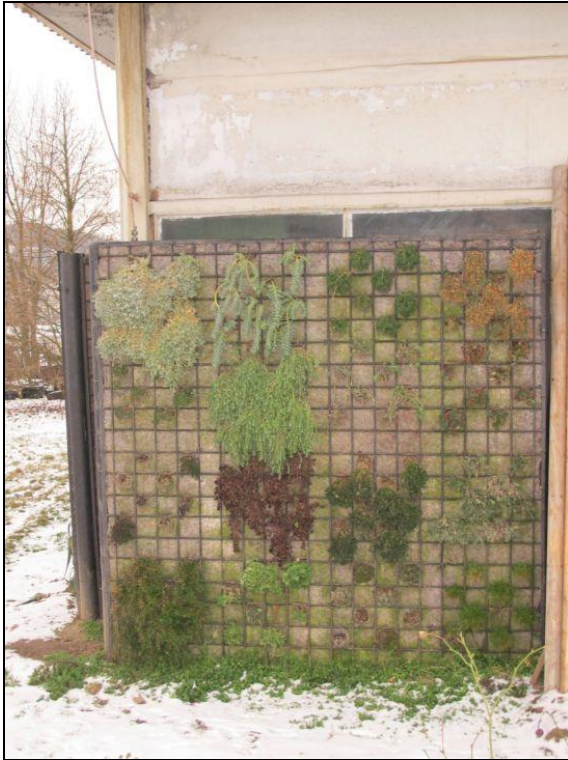
Foto 118: Stěna E (10.2.2014, autor: Petra Suldovská)
