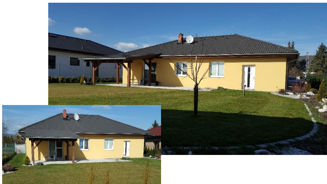
Obr. 21: Fotka řešeného domu (Zdroj: Svatoš K., 2020)
