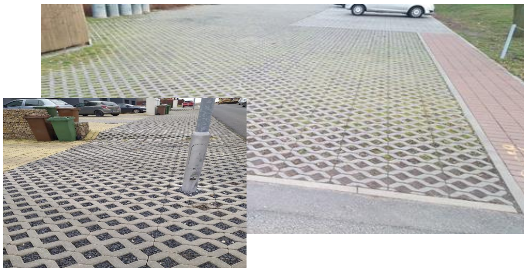
Obr. 25: Návrh zatravnovací dlažby (Zdroj: Svatoš K., 2020).
