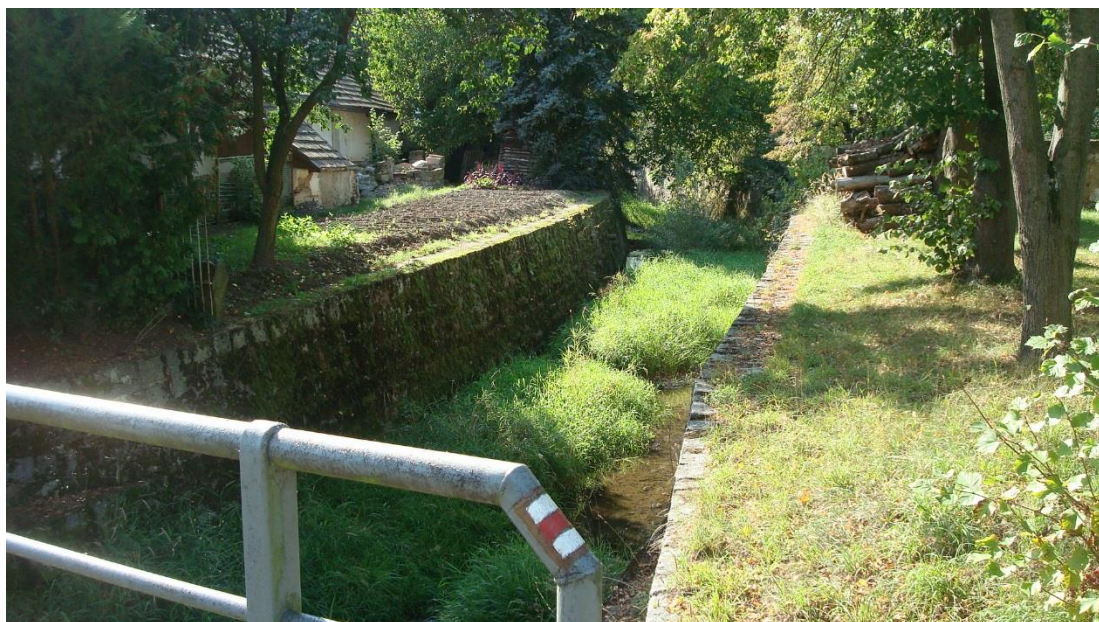
Obrázek 12 Souvislá úprava koryta v úseku TRE_002. Pohled západním směrem ze silničního mostu v obci.
