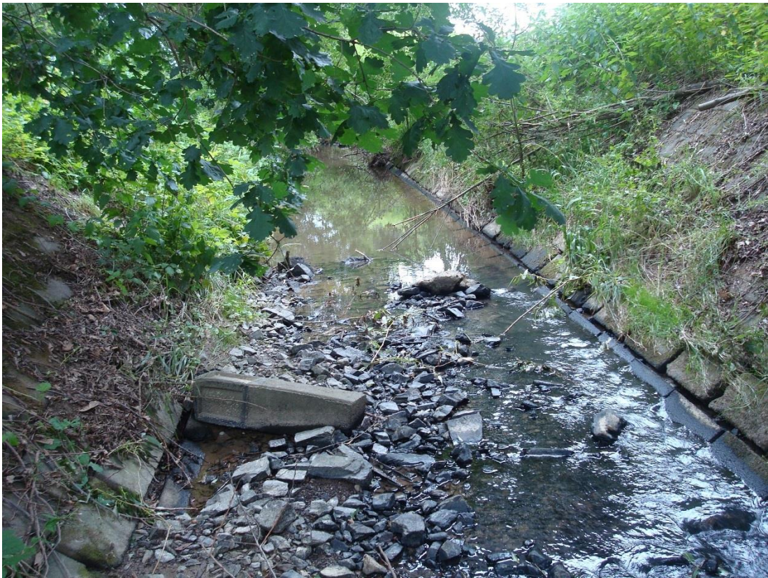
Obrázek 8 Část úseku s opevněním dna a břehů
