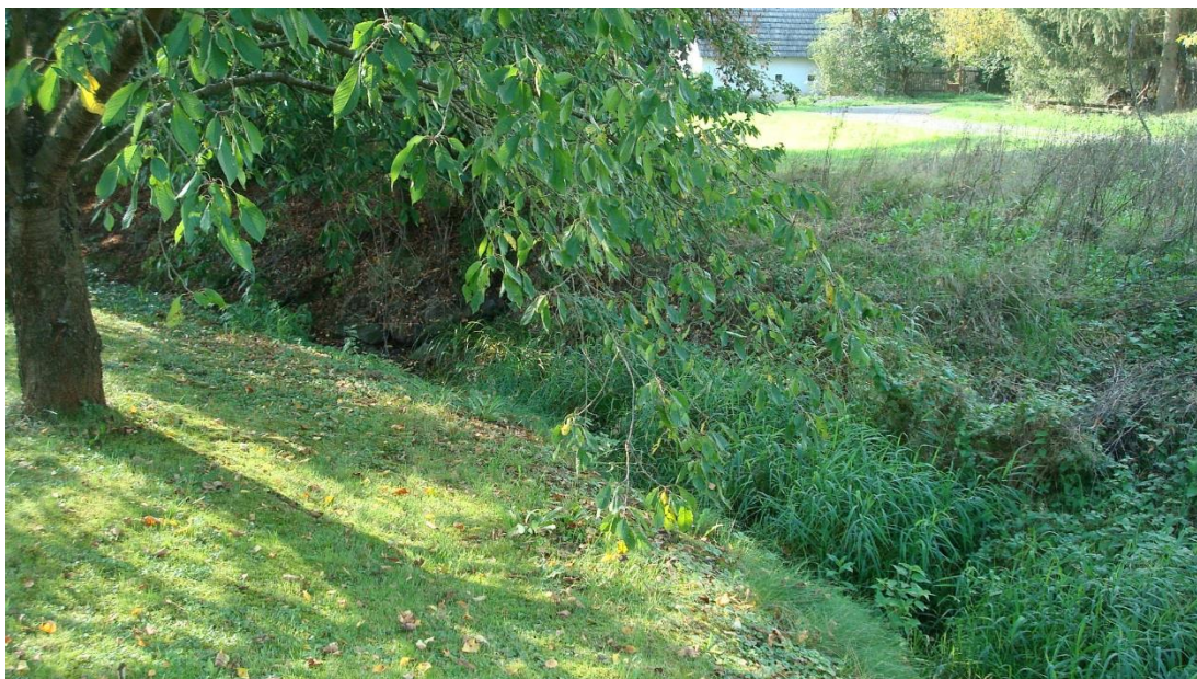
Obrázek 31 Část koryta úseku TRE_008 bez technického opevnění. Pohled směr západ.
