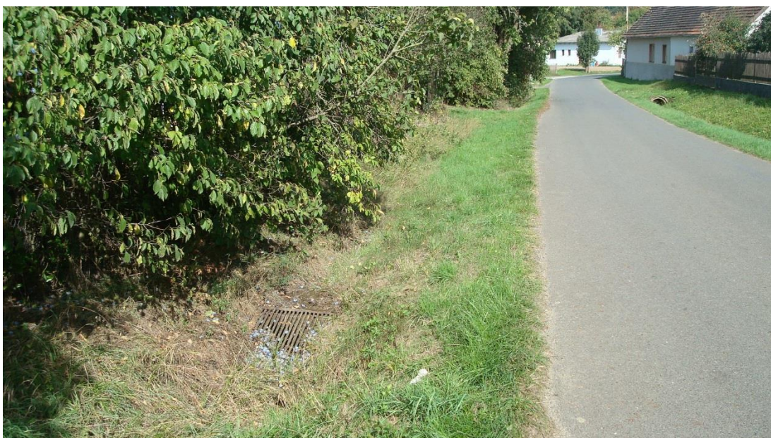
Obrázek 62 Vpust' do potrubí reprezentující úsek BP1_001.
