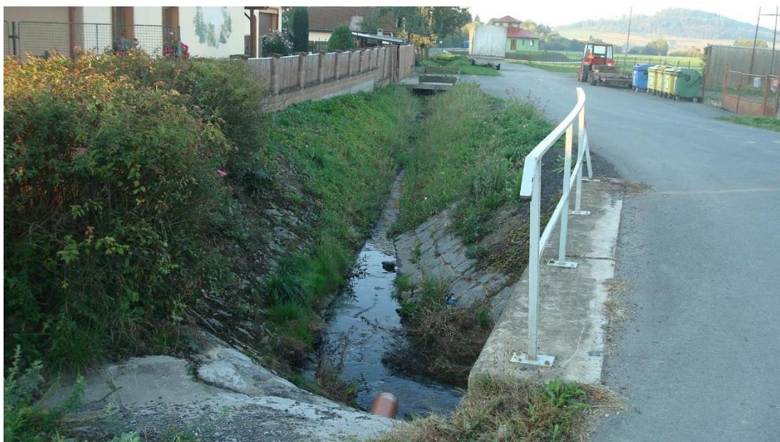
Obrázek 45 Pohled směrem na západ z mostu v obci měčín. Úsek TRE_012.
