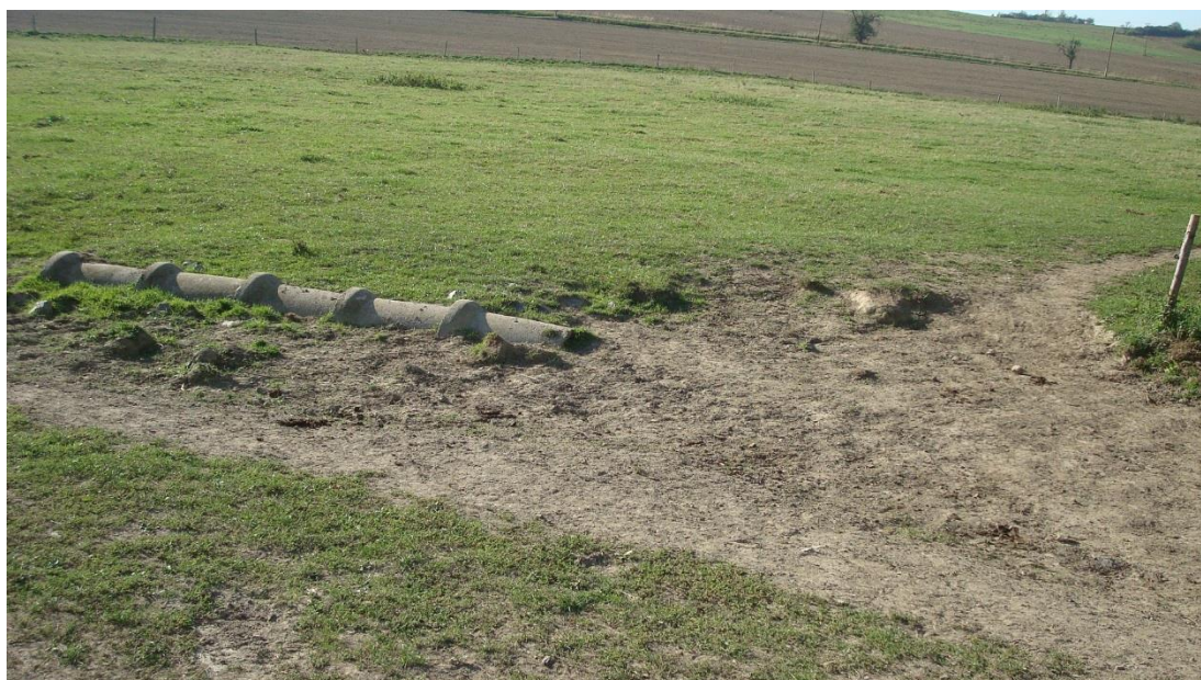
Obrázek 56 Zatrubněná část úseku TRE_016. Začátek úseku.
