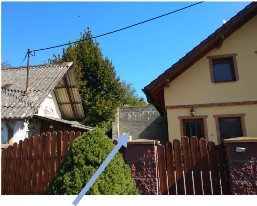
Obr. č. 6-2: Postavená zeď patřící k rodinnému domu z důvodu uříznutí paty svahu
