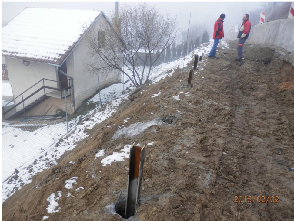
Obr. č. 5-4: Osazení zápor [2]
