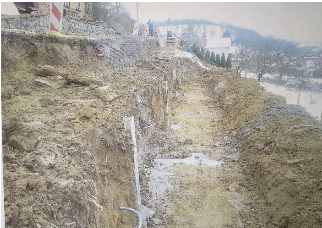
Obr. č. 5-8: Spodní záporová stěna [1]
