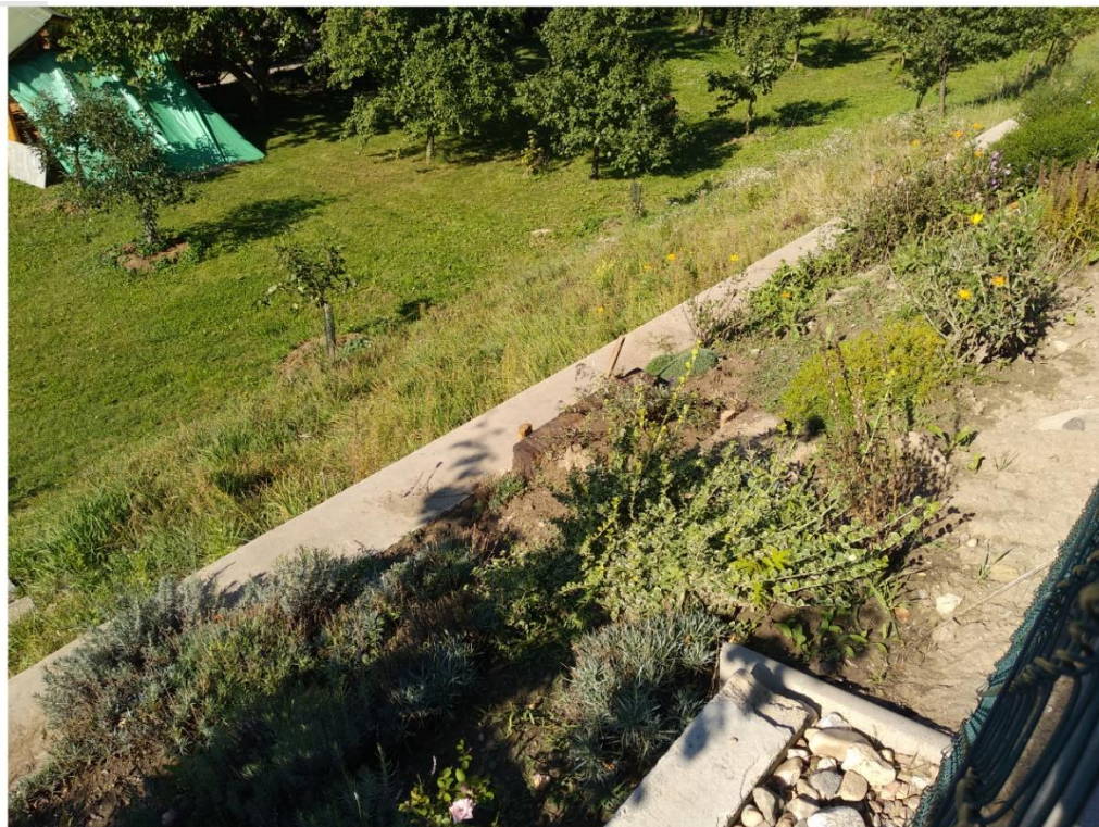
Obr. č. 6-6: Zakončení vrchní stabilizující zdi
