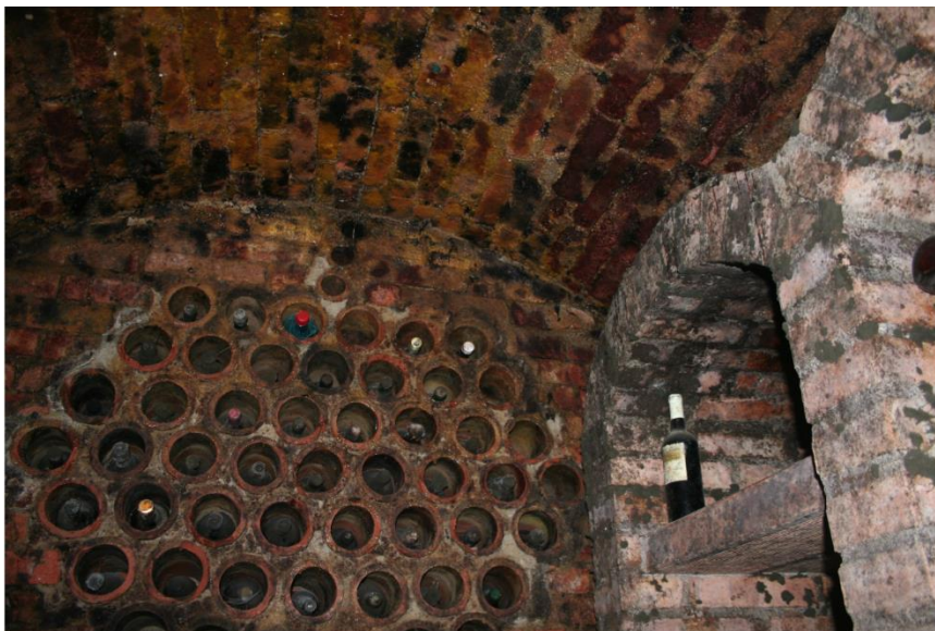
Obr. č. 2-6: Ostění vinného sklípku ve svahu pod vozovkou [2]
