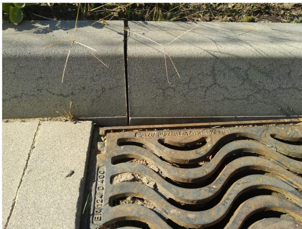
Obr. č. 6-7: Rozevírání segmentů obrubníku (nedokončená práce)
