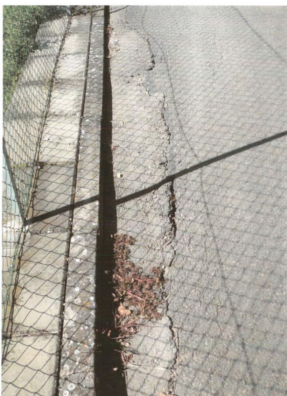
Obr. č. 2-16: Zapravení vozovky asfaltem u obrubníku [3]
