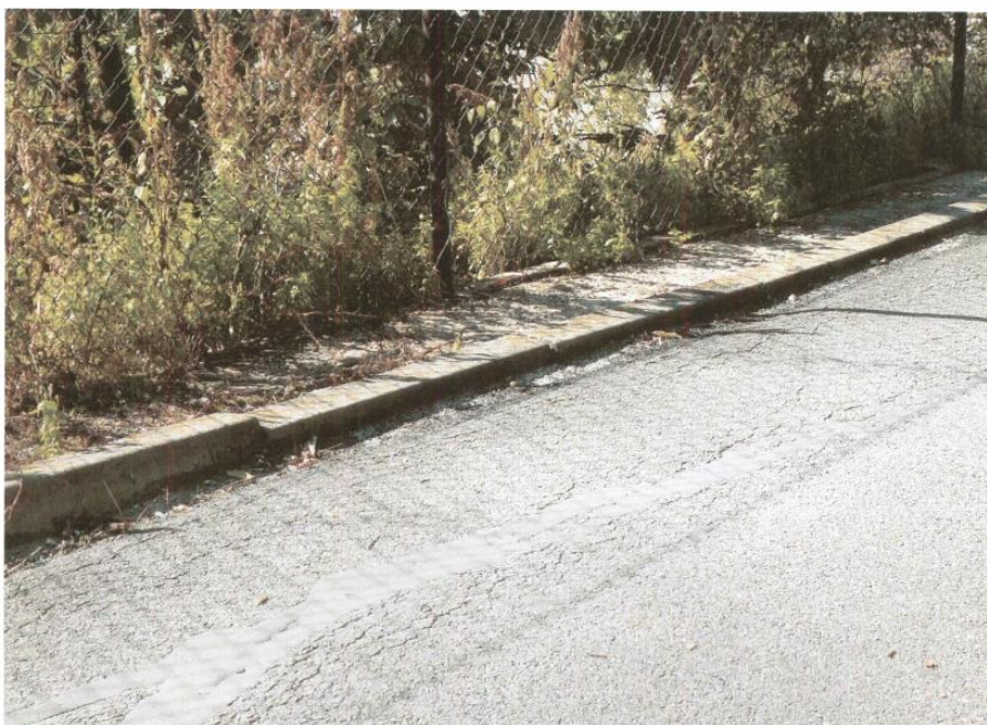
Obr. č. 2-15: Zapravení vozovky asfaltem a svislý posun obrubníku [3]
