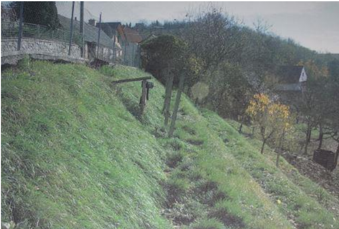
Obr. č. 2-11: Pohled na terasovitě upravený svah pod RD č. 166 (předaný zadavatelem) [1]
