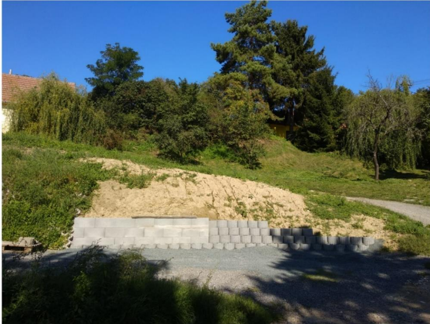
Obr. č. 6-1: Stavění malé zidky zajišťující svah v blízkosti sanovaného území a nenakloněné stromy (pouze ojedinele) značící klid svahu
