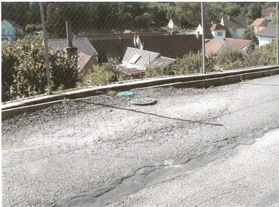
Obr. č. 2-14: Zapravení vozovky asfaltem [3]
