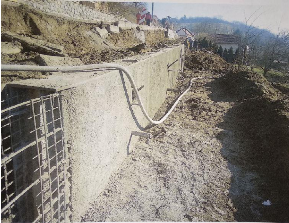
Obr. č. 5-10: Spodní záporová stěna[1]
