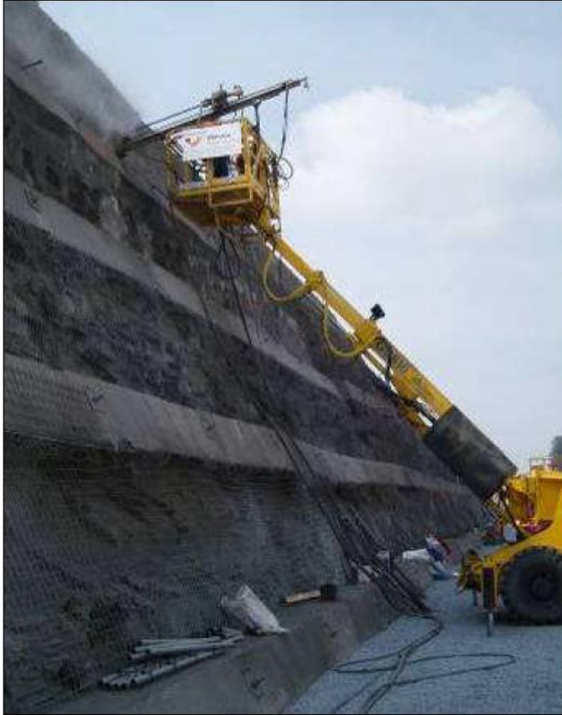
Obr. č. 9-3: Maloprofilová vrtací souprava MORATH [9]
