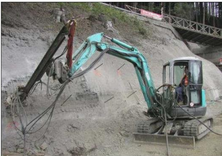
Obr. č. 9-4: Maloprofilová vrtací souprava MORATH [9]
