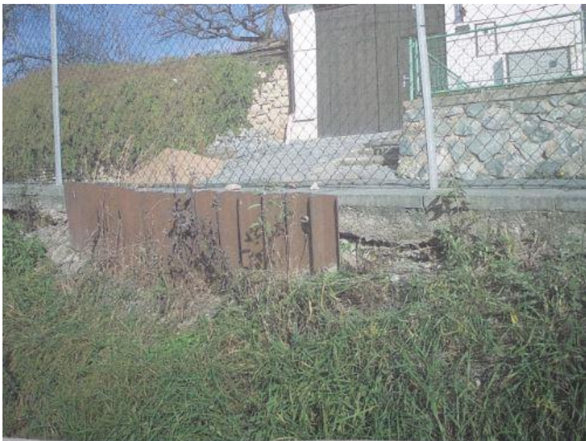
Obr. č. 2-12: Detail obr. č. 2-11 – provizorní zabezpečení koruny svahu u vozovky [1]
