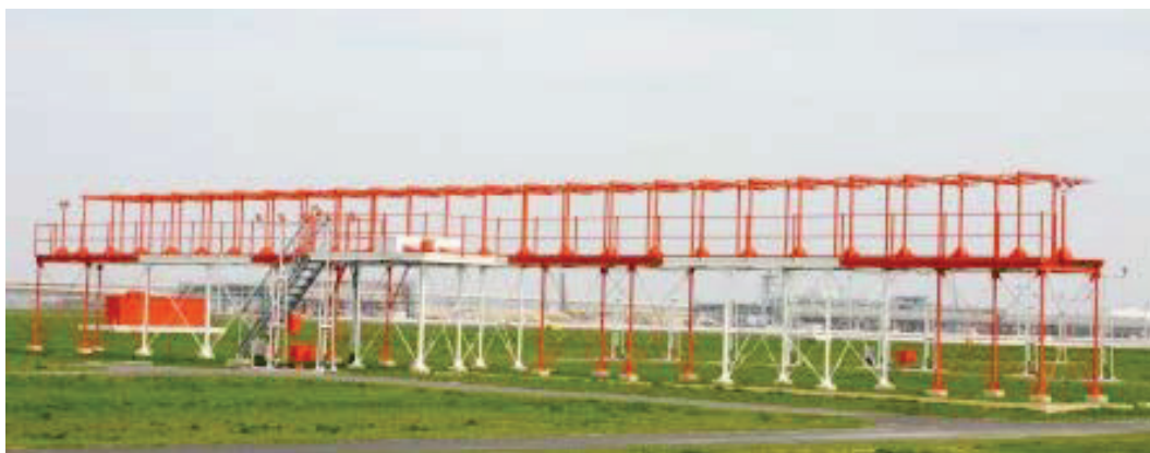
Obr. 3 LLZ anténa [http://www.pilotfriend.com]
