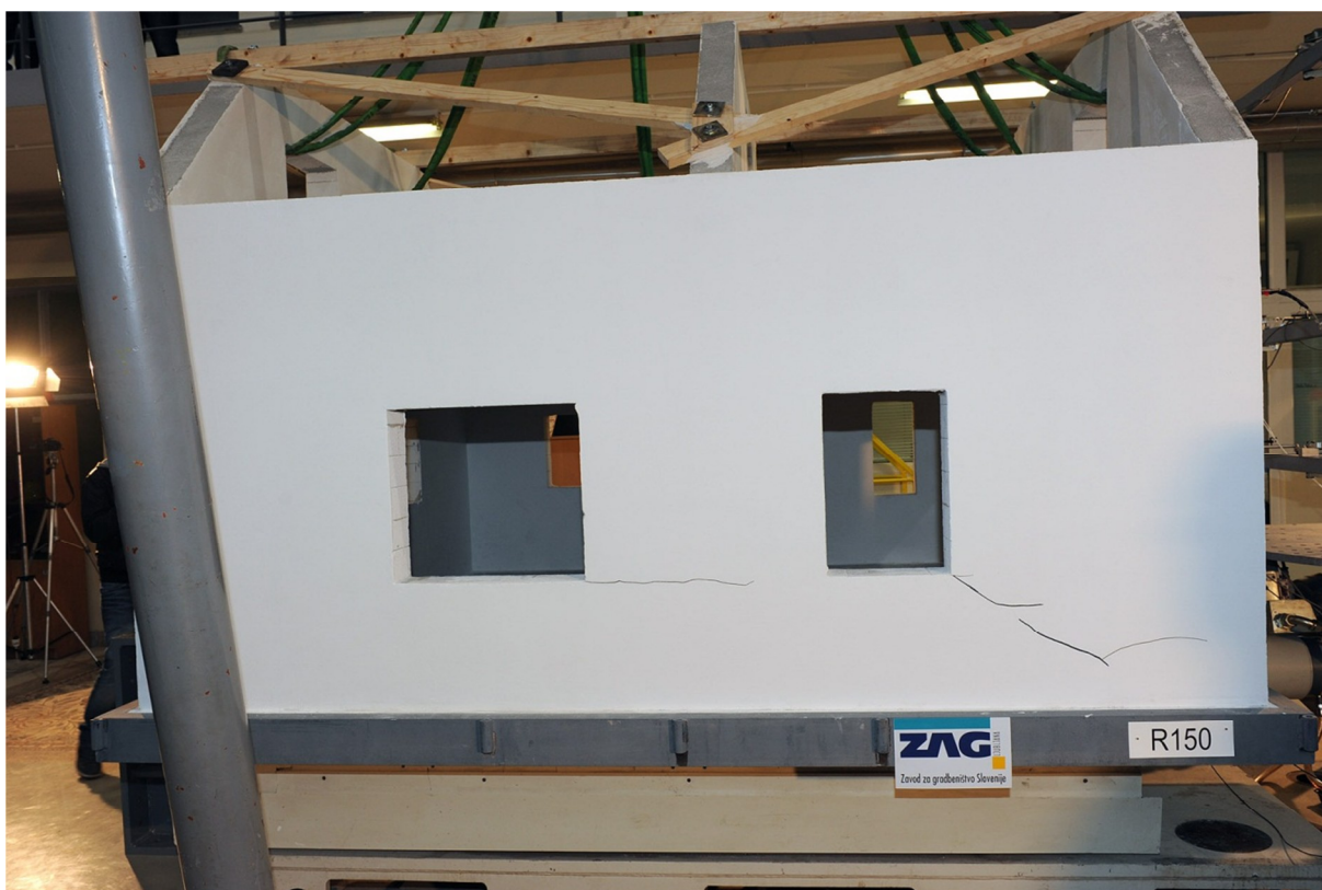
Obr. P5.2 Porušení při zatížení na úrovni G150
