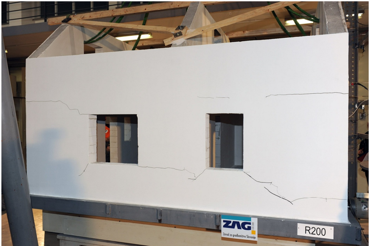
Obr. P5.3 Porušení při zatížení na úrovni G200
