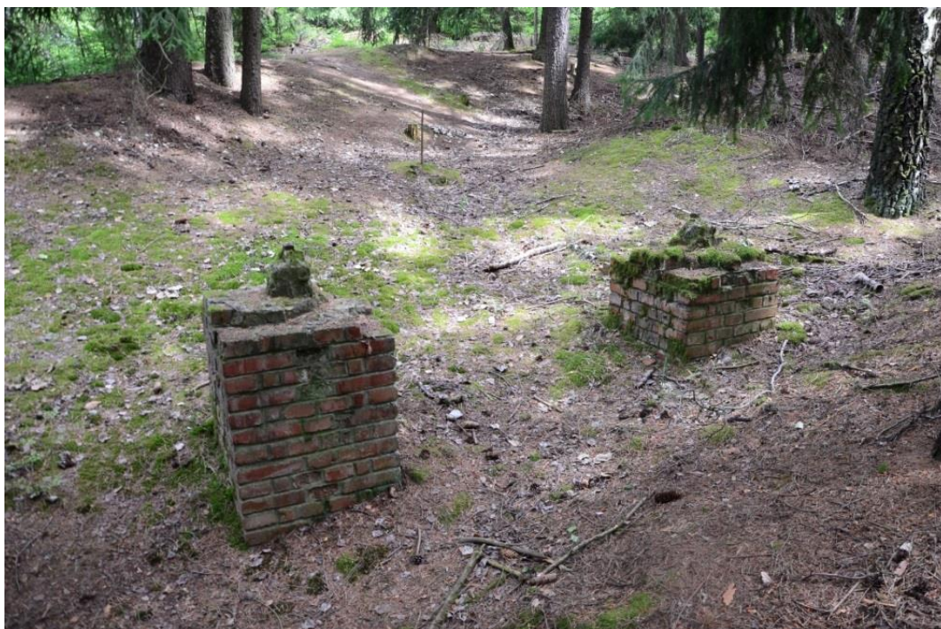
Obrázek č. 7: Pozůstatky cihlových patek sloupu z lanovky (zdroj: archiv autora)
