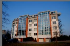
budova pedagogů, NC
