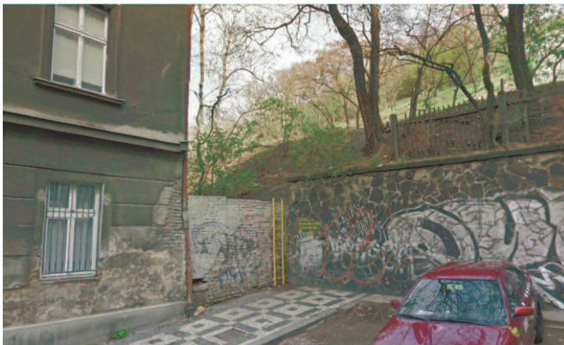
Obrázek č. 2 – Jeronýmova ulice, nelegální instalace žebříku
