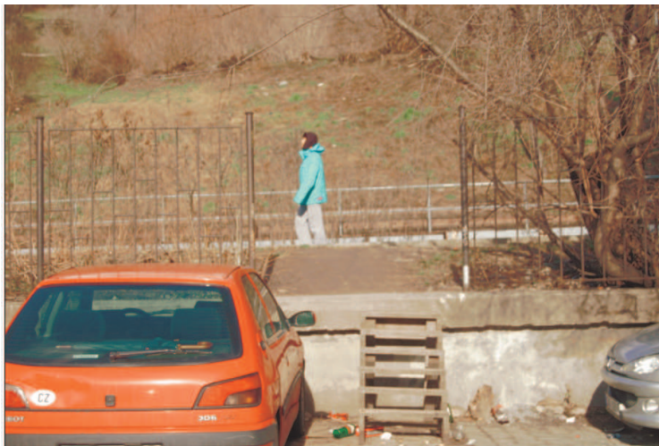
Obrázek č. 4 Tachovské náměstí – provizorní schodiště
