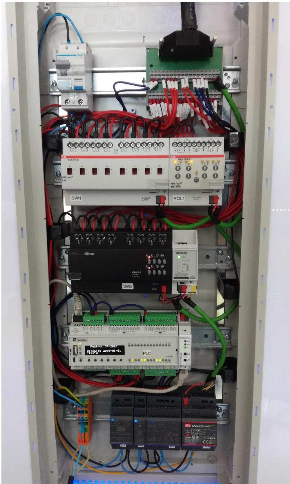
Obrázek 28 – Zapojení rozváděče
