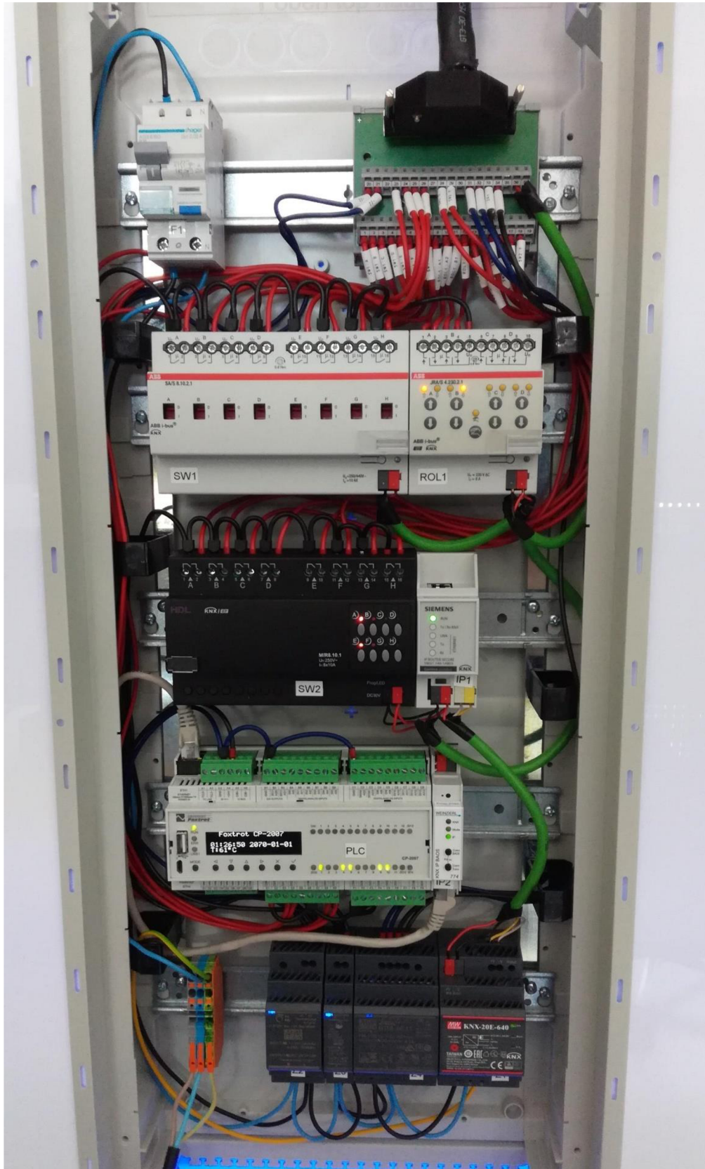
Obrázek 28 – Zapojení rozváděče
