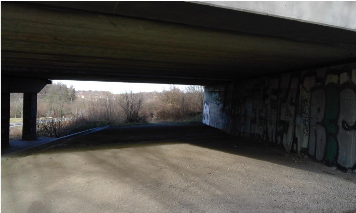
Obr.č.12 Podchod pod dálnicí, zdroj: autor, 2017
