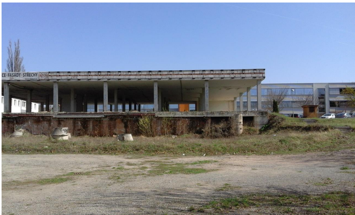
Obr.č.17, Areál na ulici Kaštanová, zdroj: autor, 2017
