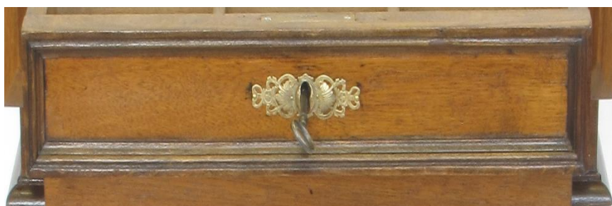
Obrázek 32 - Doplněné kování na zásuvce (Vlastní fotografie)
