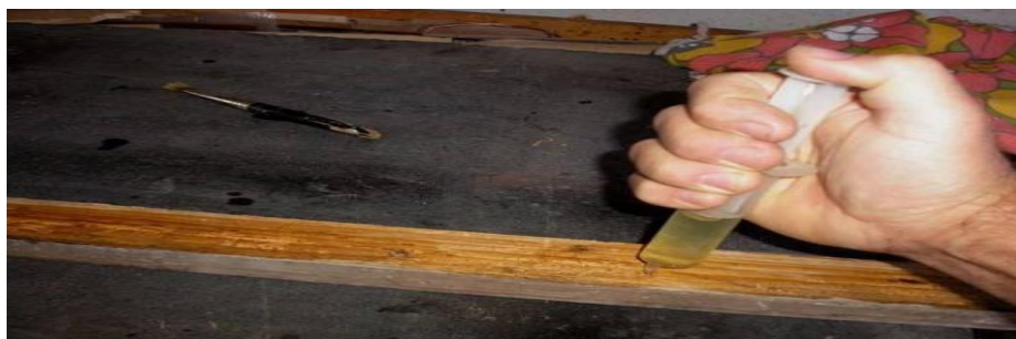
Obrázek 3 - Petrifikace pryskyřicí napadené části pro zpevnění materiálu, římsy
