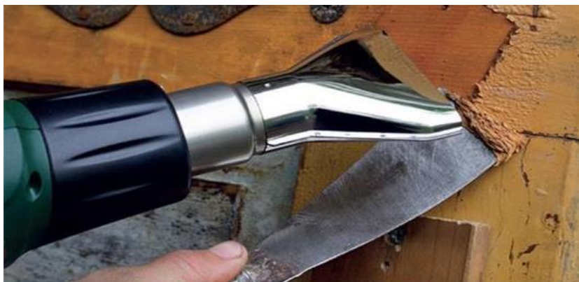
Obrázek 21 - odstranění nátěru pomocí horkovzdušné pistole
