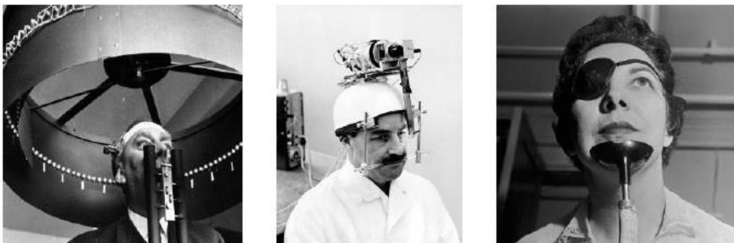
Obrázek 2: První podoba předchůdců eye trackerových zařízení, různé varianty
