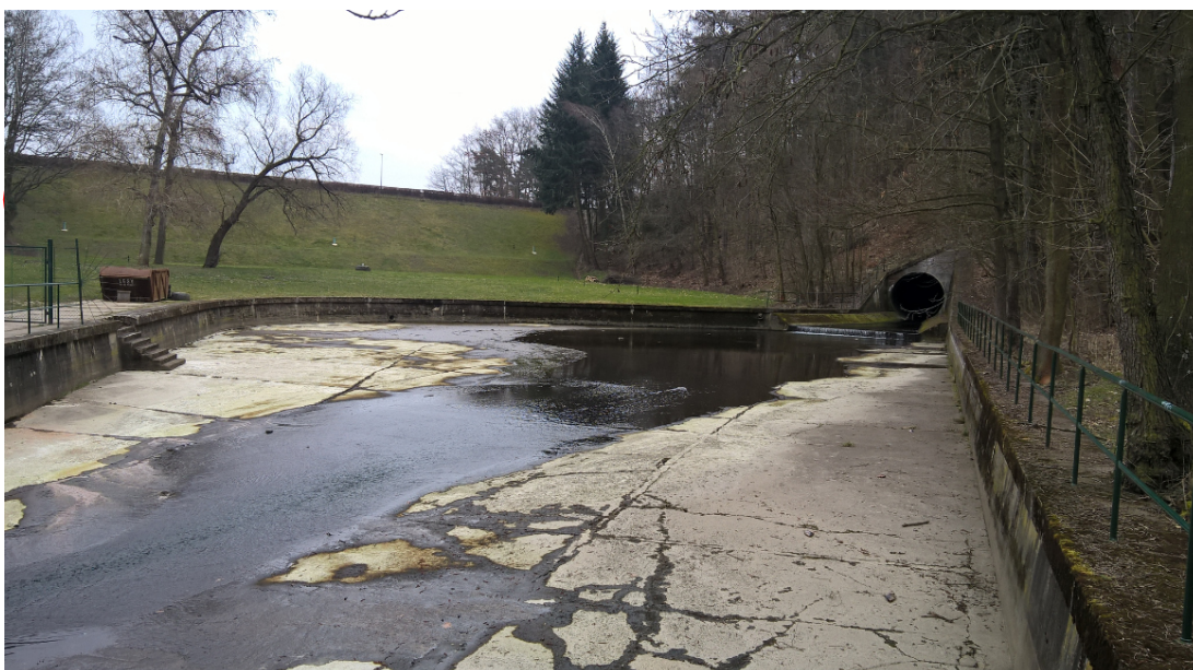
Příloha č. 31 Pohled od vývaru na vyznačenou hráz a odtokové potrubí vodní nádrže Hostivař. (autor, 2015)
