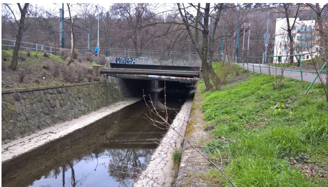
Obr. č. 9 Poslední metry toku před zaústěním pod zem v ulici Na Slupi. (autor, 2015)
