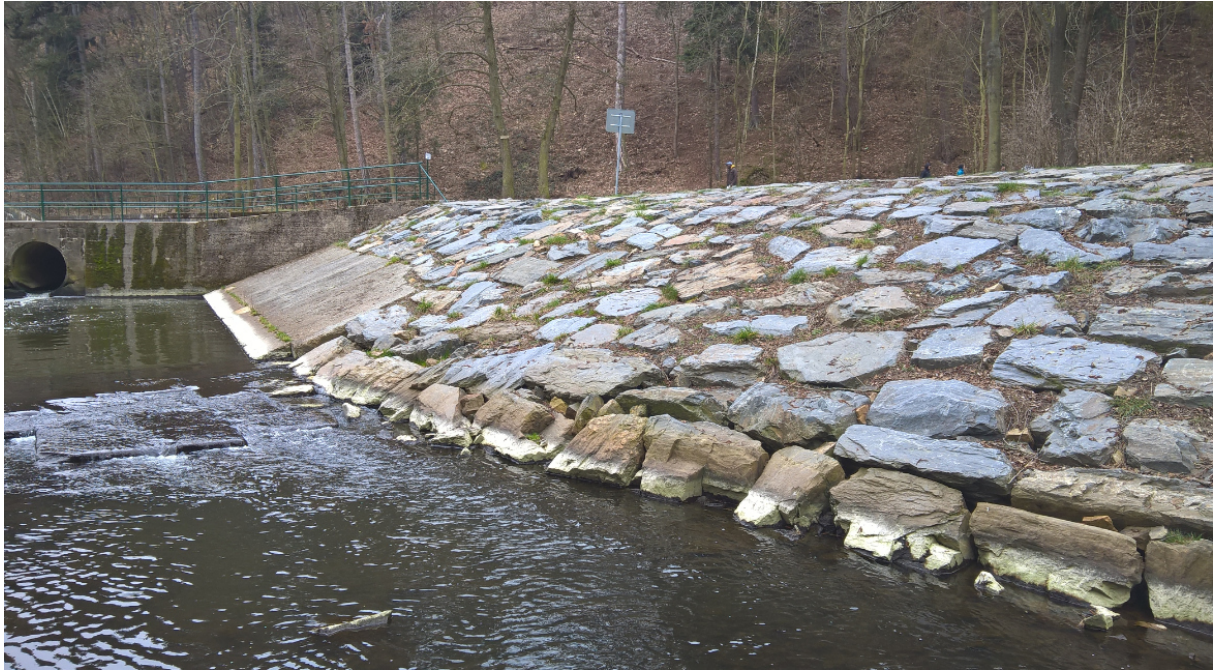
Příloha č. 36 Pohled na opravené opevnění vývaru pod vodní nádrží Hostivař. (autor, 2016)
