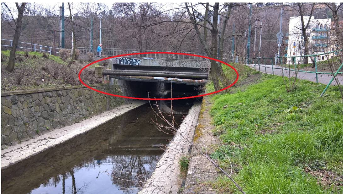
Příloha č. 14 Na snímku jsou označeny červeně inženýrské sítě, které jsou vedeny v korytě toku. (autor, 2015)
