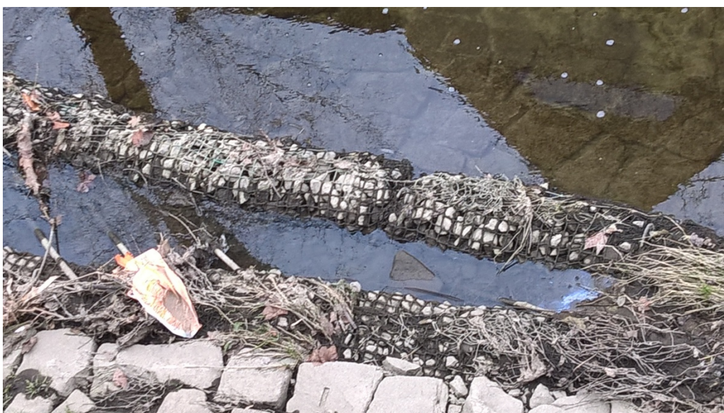
Obr. č. 10 Kamenný válec pokrytý sítí bez mokřadních rostlin a jiné vegetace po povodních. (autor, 2015)
