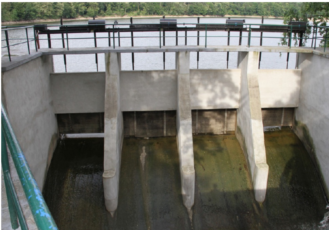
Obr. č. 15 Bezpečnostní přeliv se 4 stavidly na vodní nádrži Hostivař. (autor, 2015)
