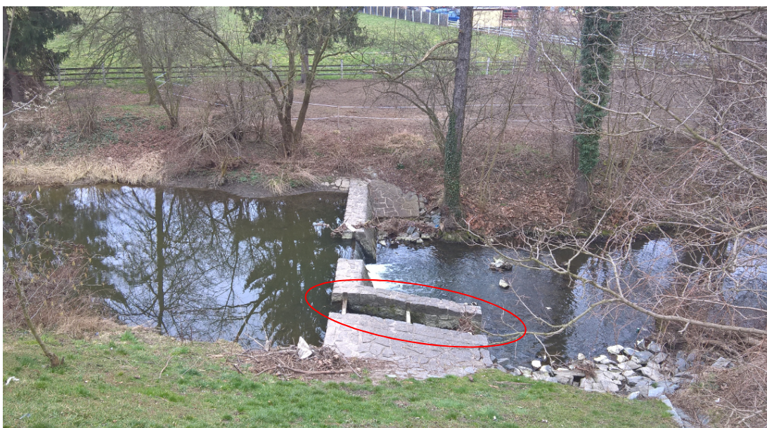
Příloha č. 29 Rybí přechod v ulici U Břehu, který bude nahrazen kamenitým skluzem. (autor, 2015)
