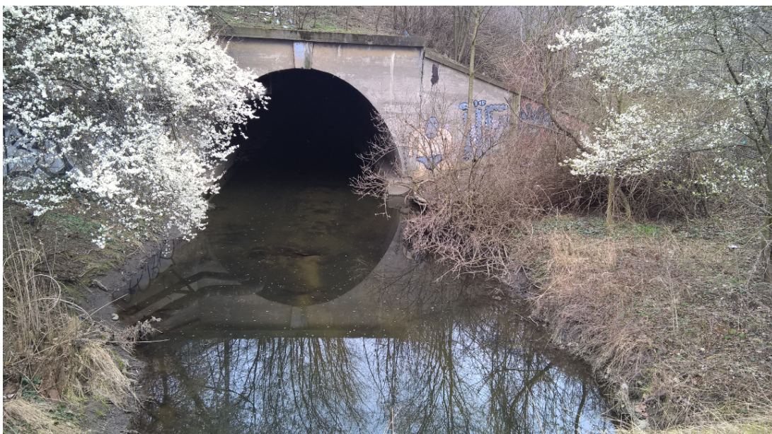
Příloha č. 22 Vyústění vodního toku ze zaklenutí pod vlakovým nádražím. (autor, 2016)
