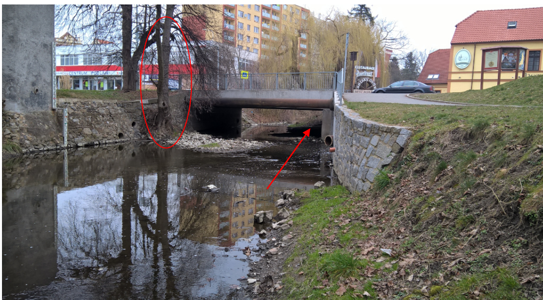
Příloha č. 27 Most v ulici K Horkám, kde je označen strom v korytě toku a za mostem je vidět část přeložky potrubí. (autor, 2015)
