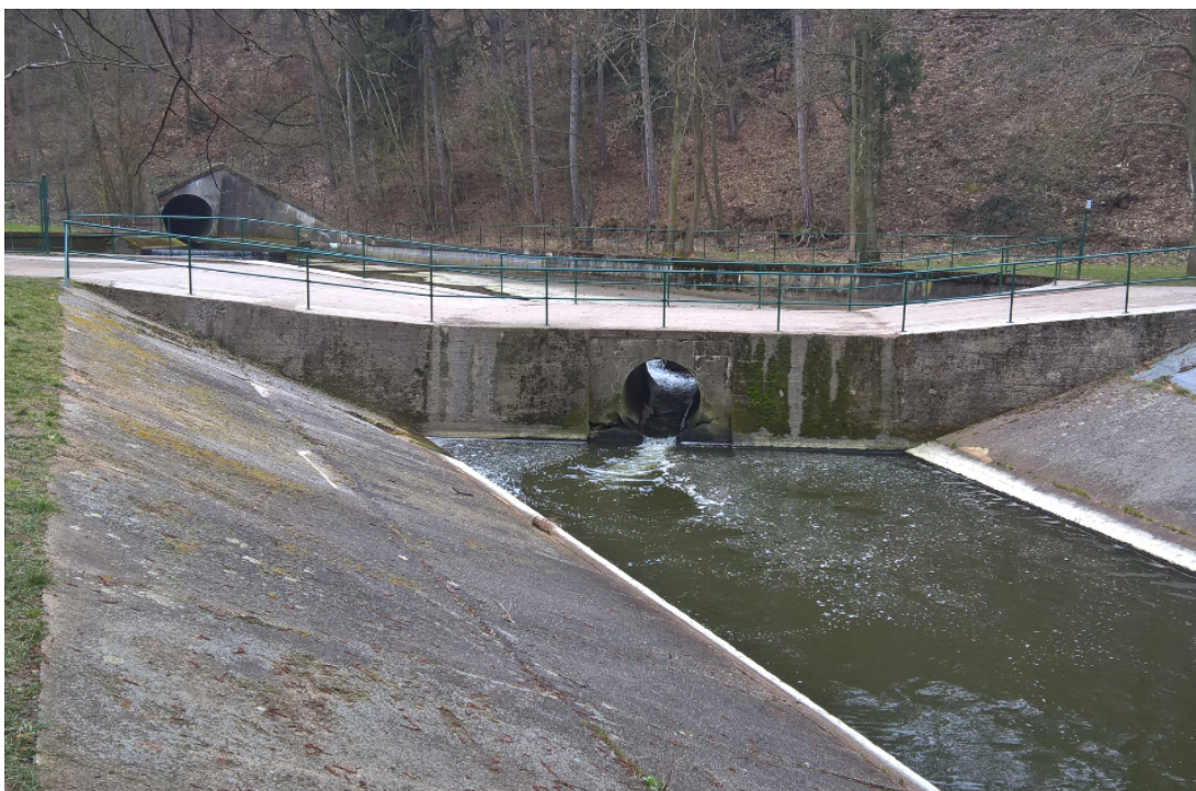
Příloha č. 12 Vývar pod vodní nádrží Hostivař při normálním odtoku z nádrže. (autor, 2015)
