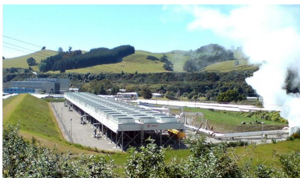
Obr. 5 Geotermální elektrárna Wairakei – Nový Zéland [14]
