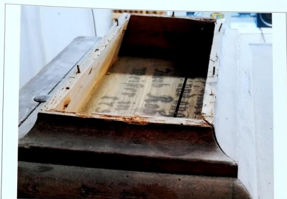
Detail poškození stýných ploch masivních profilových listů.
