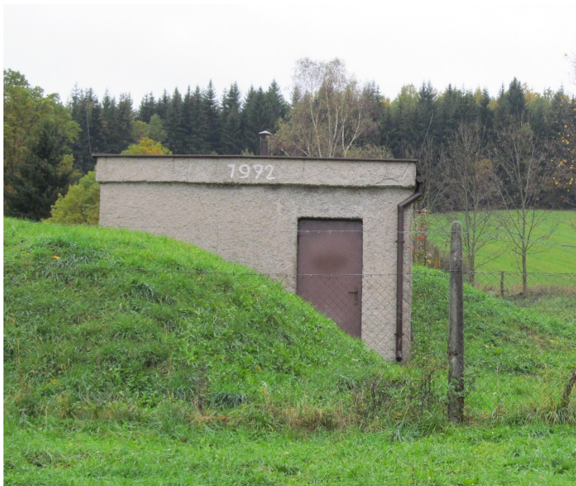
Obr. 4 Zemní vodojem v obci Hrádek.
