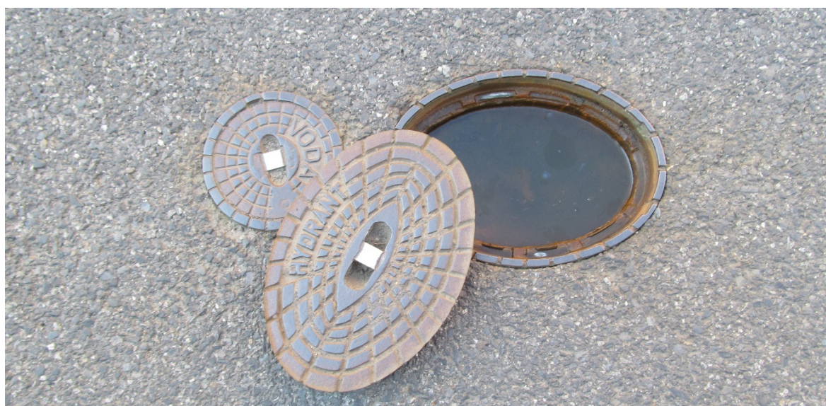
Obr. 29 Fotografie otevřeného podzemního hydrantu zařazeného do kategorie K3.
