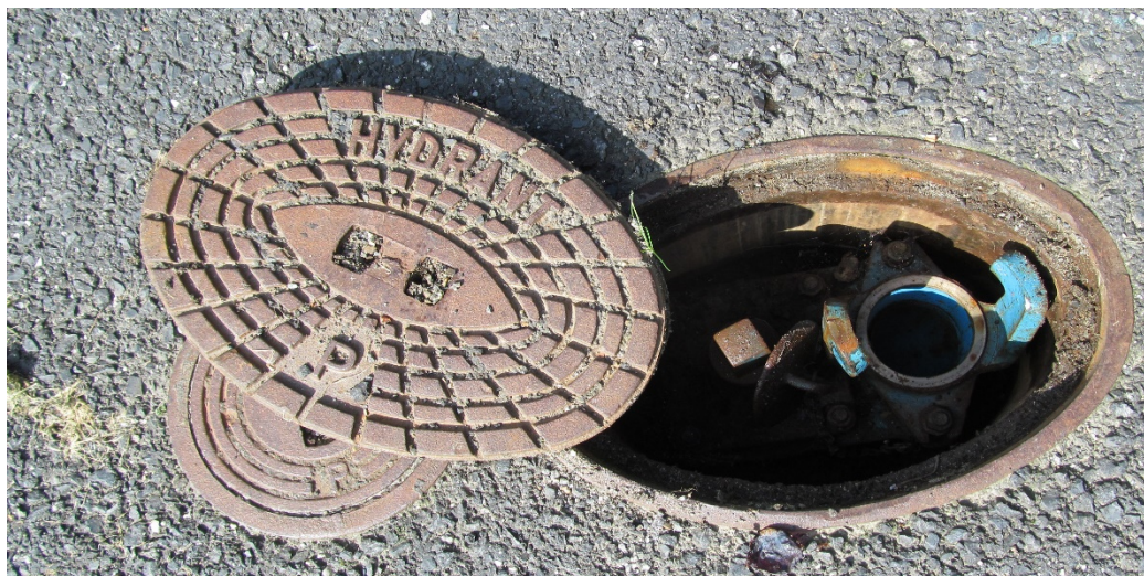
Obr. 27 Fotografie otevřeného podzemního hydrantu zařazeného do kategorie K1.
