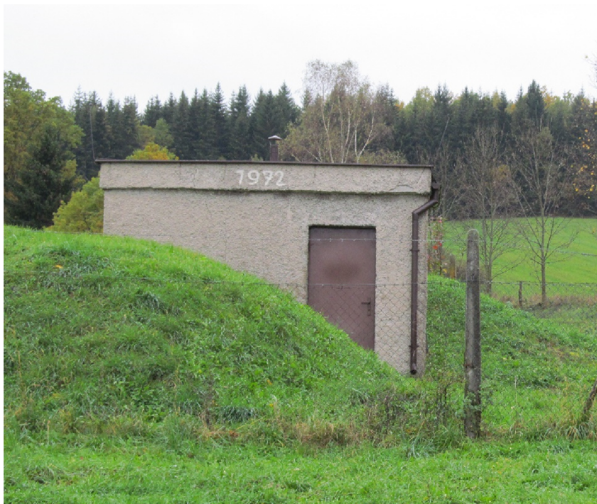
Obr. 4 Zemní vodojem v obci Hrádek.
