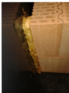
Obr. 29 Nedoléhající strana vyplněna zdicí pěnou
