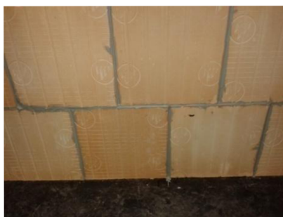
Obr. 30 Spáry vyplněné butylenovým tmelem
