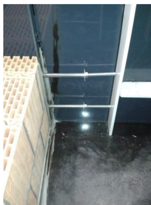
Obr. 32 Zajištění lišt rozepřemi
