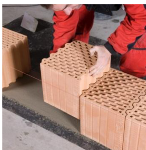
Obr. 11 Zakládání první vrstvy [57]
