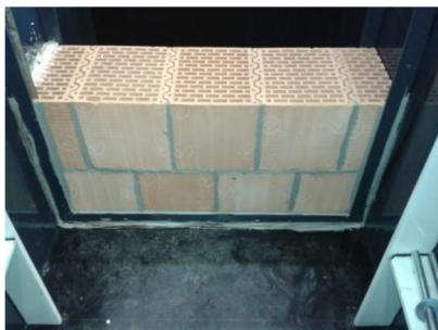
Obr. 31 Stěna opatřená ochrannými lištami
