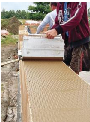
Obr. 13 Zdění na celoplošnou spáru [60]
