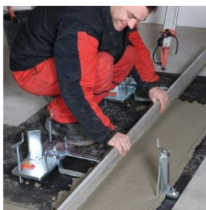
Obr. 10 Nanášení vyrovnávací malty [56]
