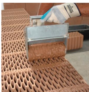
Obr. 12 Nanášení malty pomocí nanášecího válce [58]
