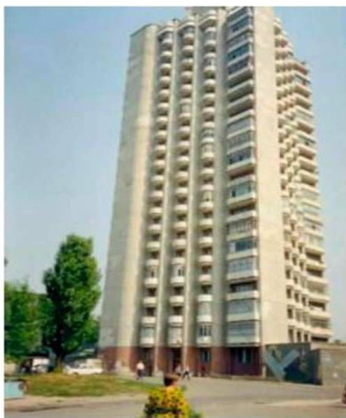
Obrázok 1: Prvý bytový dom postavený v roku 1989 v Lipetsku, z betónu z alkalicky aktivovanej trosky (bez portlandského cementu) [19; 20].
