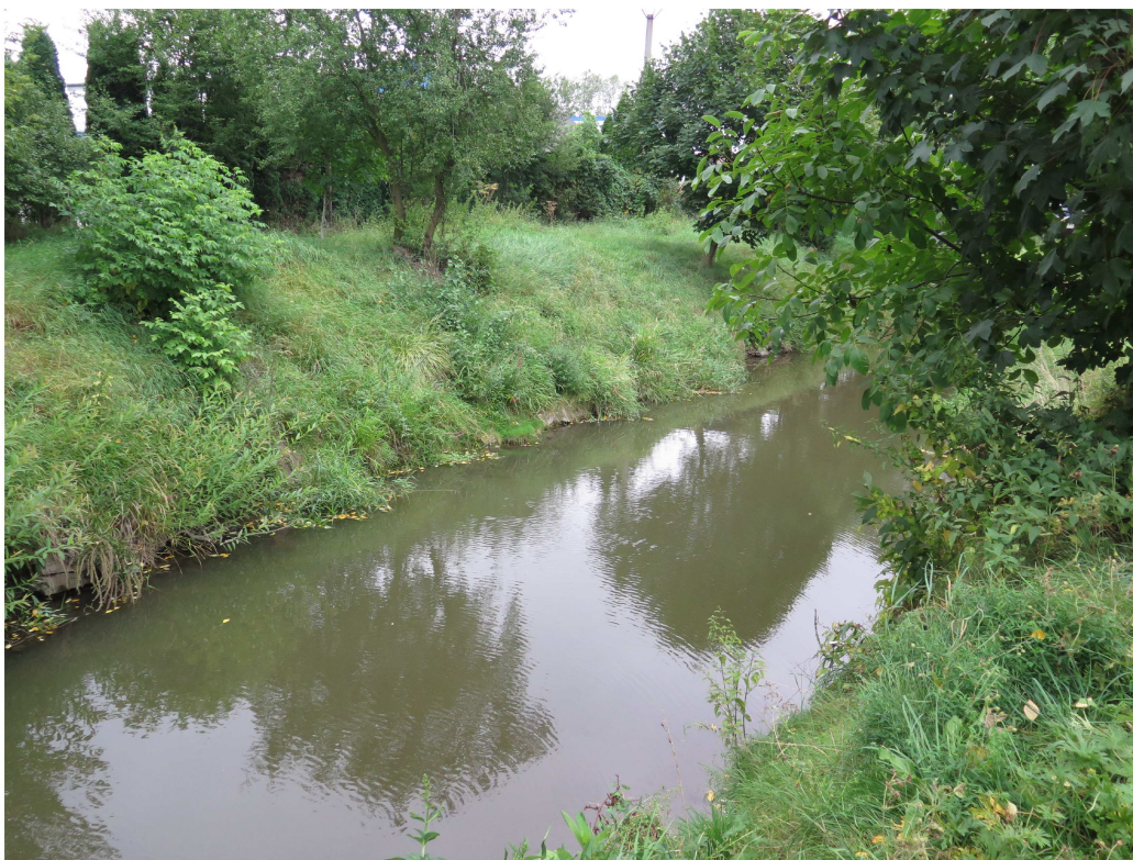
Obrázek 11: II. dílčí úsek Romže, hospodářský most.
