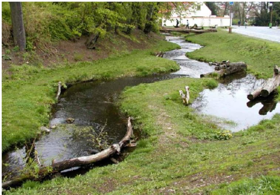
Obrázek 26: Příklad návrhu přírodě blízkého protipovodňového opatření se stěhovavou kynetou. [11]
