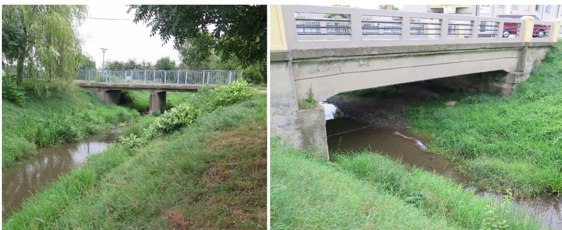
Obrázek 24: Hospodářský most M4 v ř. km 1,616 (vlevo), silniční most M7 v ř. km 2,234 (vpravo)
