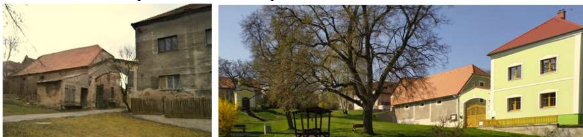
Obrázek 17 - Areál čp. 1, hlavní budova; pohled z návsi
