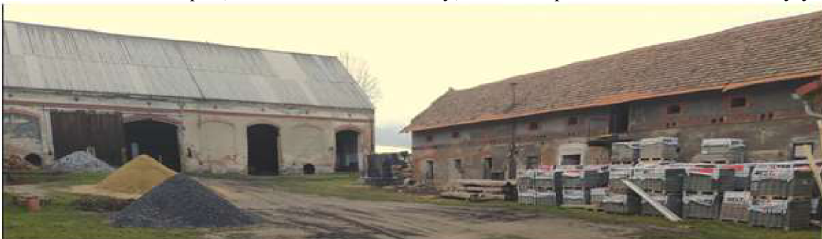
Obrázek 19 - Areál čp. 1, stodola a severní chlěvy; budoucí sportovní hala a sociální byty
