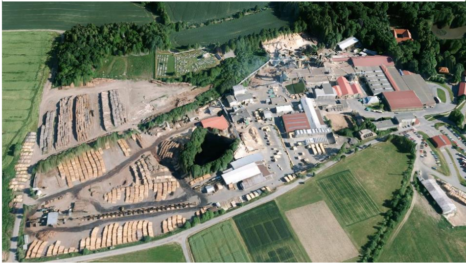
Obrázek 1 Letecký pohled na Dřevozpracující družstvo Lukavec
