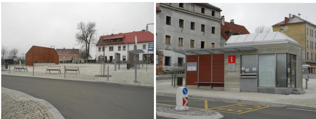
Obrázek 28 Rekonstruované náměstí Abertamy a Informační centrum města
