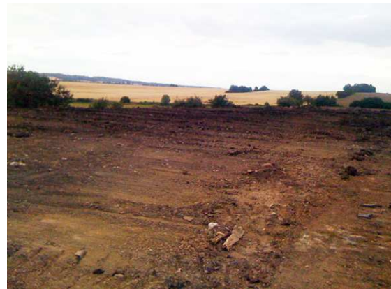
Obr. č. 11 Terénní úprava pozemku pro FVE Unhošť ( http://www.deponiainvest.cz )
