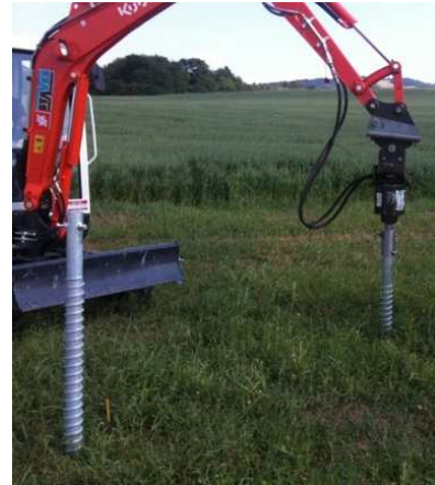
Obr. č. 14 Mikropiloty ( http://www.doznac.cz/ )
