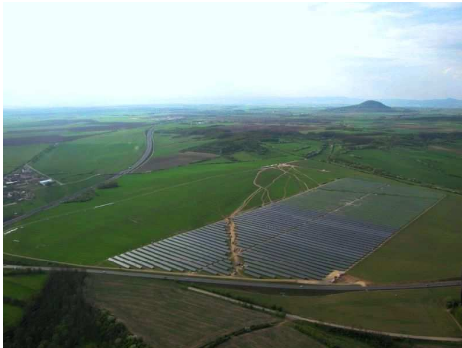
Obr. č. 2 FVE u obce Vepřek na Mělnicku, rozloha 82,5ha ( http://www.phonosolar.cz/ )
