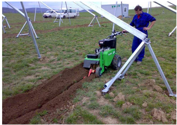
Obr. č. 12 Drážkování pro uzemnění a kabeláže FVE Pesany www.pin292.cz
