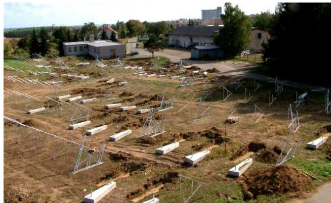
Obr. č. 13 FVE Moravské Budějovice – instalace na betonových patkách ( http://www.fames.cz/ )
