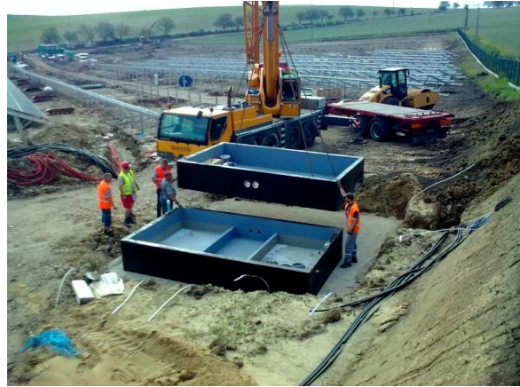
Obr. č. 10 Výstavba FVE Bohumilice ( http://www.eeikasafranek.cz )
