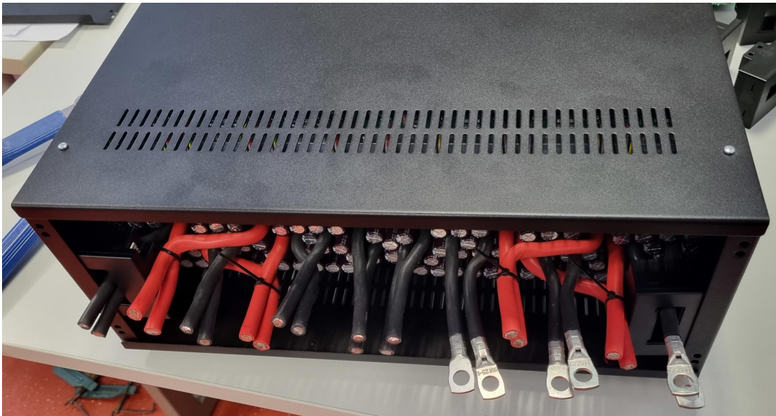
Obr. 2.13: Krimpování kabelových ok na silové vodiče
