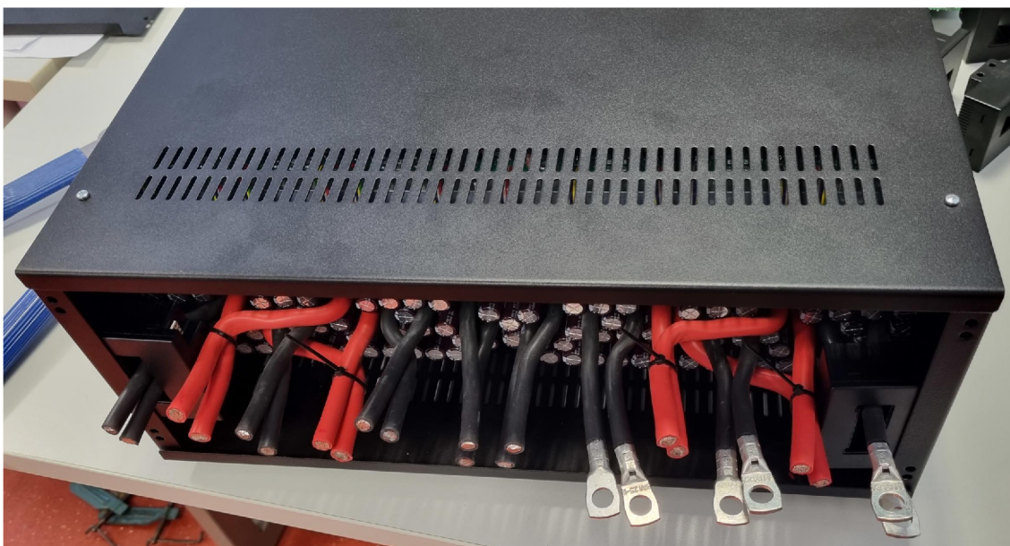
Obr. 2.13: Krimpování kabelových ok na silové vodiče
