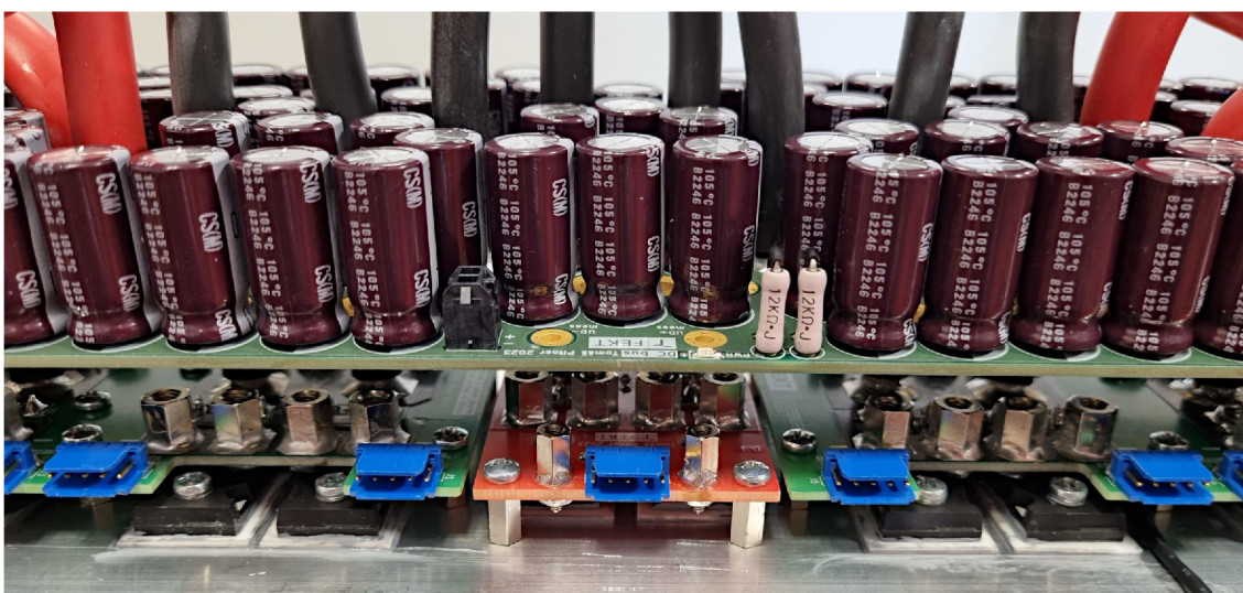
Obr. 2.6: Montáž meziobvodu – silové vodiče větví jsou provlečeny otvory v DPS
