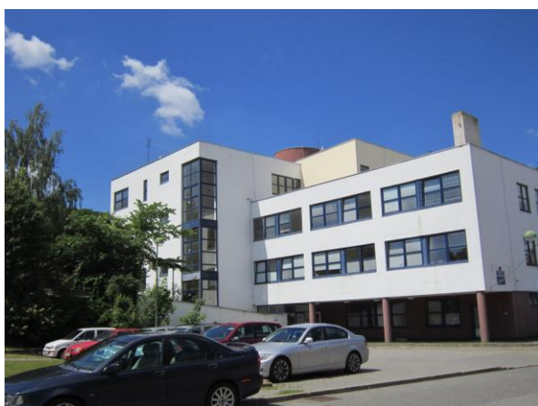
Administrativní budova, pohled z ul. Havířská
