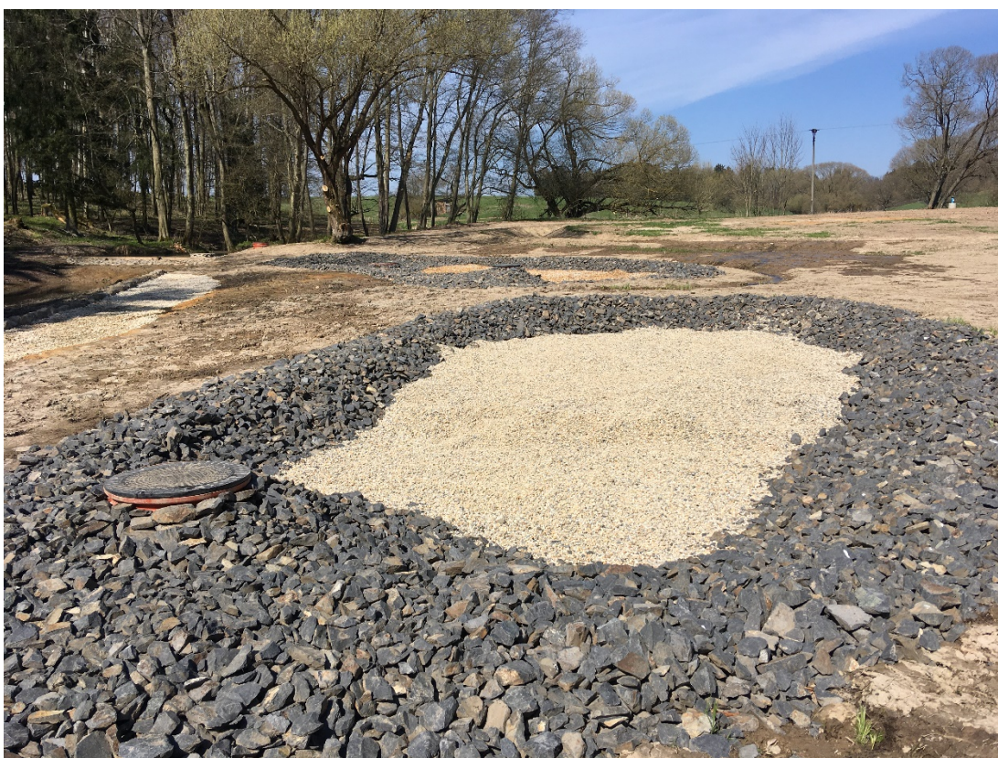
Obrázek 30: Fotografie vytvořeného hybridního mokřadu ihned po realizaci (Vymazal J. 2021)
