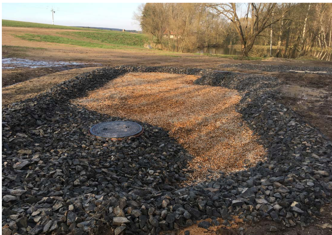
Obrázek 28: Fotografie mokřadu s horizontálním podpovrchovým průtokem ihned po realizaci (Vymazal J. 2021)
