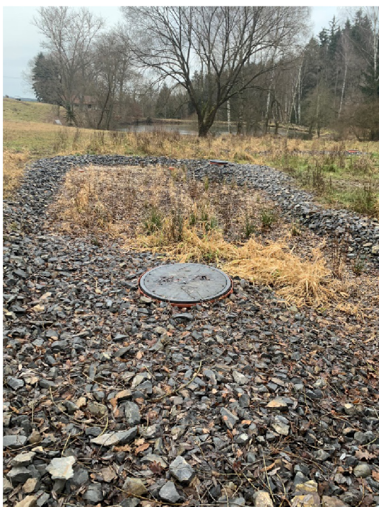
Obrázek 32: Odběrné místo CW2 – Mokřad horizontální s biofiltrem (2.1.2022 Švejdová V.)
