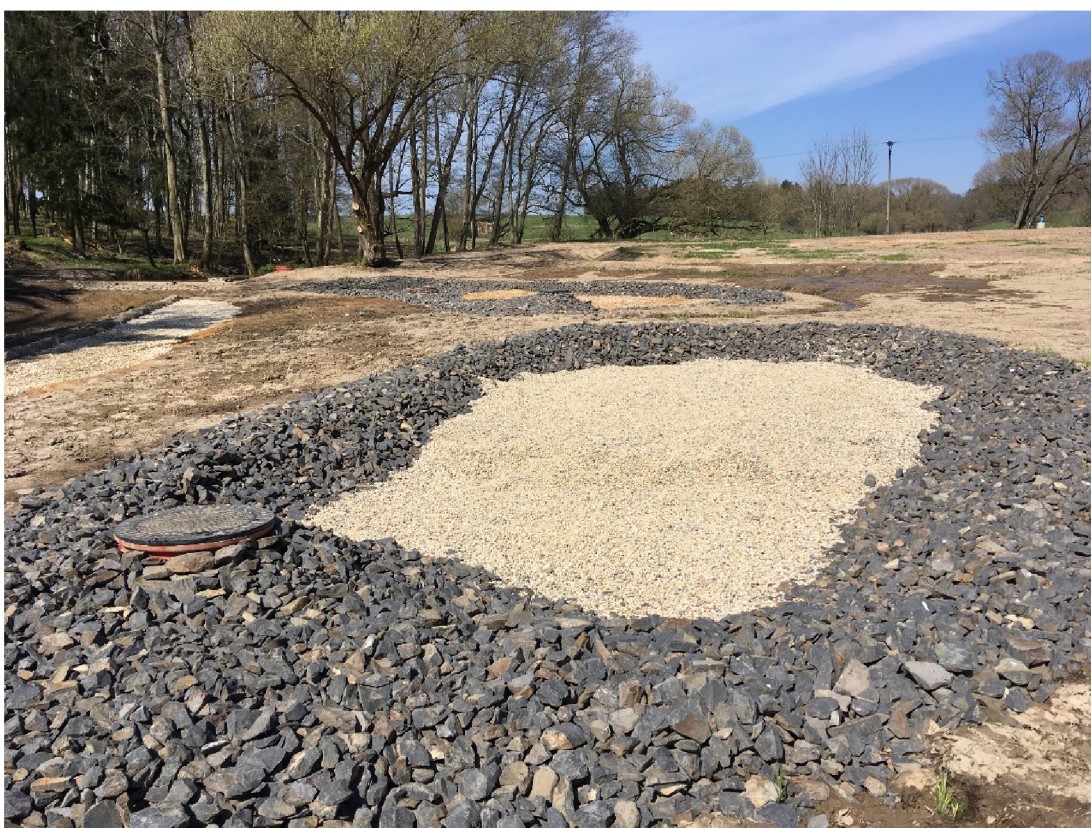
Obrázek 30: Fotografie vytvořeného hybridního mokřadu ihned po realizaci (Vymazal J. 2021)
