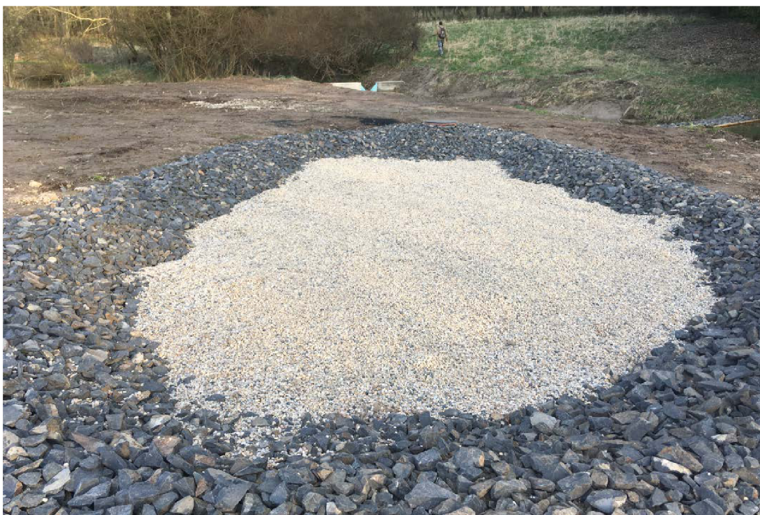
Obrázek 29: Fotografie mokřadu s vertikálním podpovrchovým průtokem ihned po realizaci (Vymazal J. 2021)
