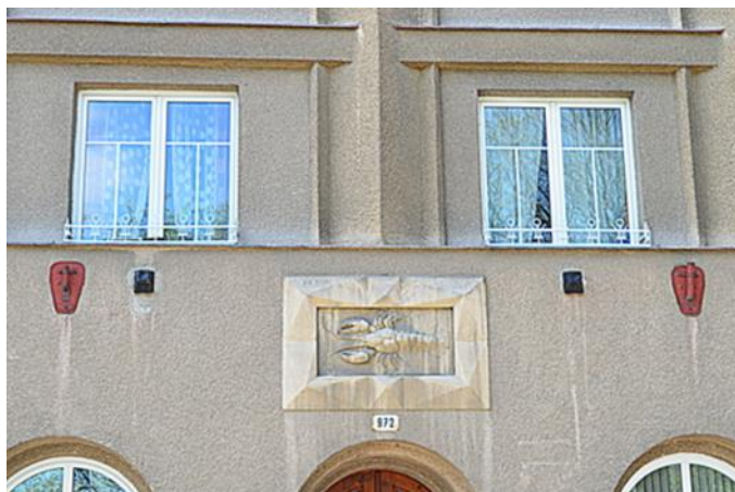
Obr. 35: Detail fasády domu čp. 972 s plastickým reliéfem raka v kubistickém rámu.
