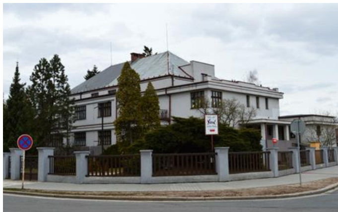
Obr. 68: Současný stav dvojvily pro dcery Rudolfa Vitouška v Třebechovicích pod Orebem.
