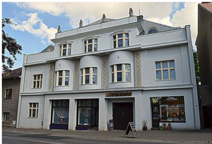
Obr. 50: Současný stav uličního průčelí Bednářovy vily po rekonstrukci.
