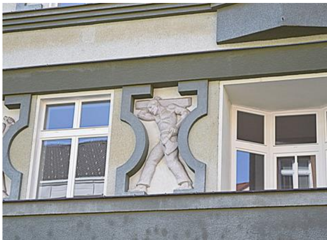
Obr. 37: Detail fasády domu čp. 994.
