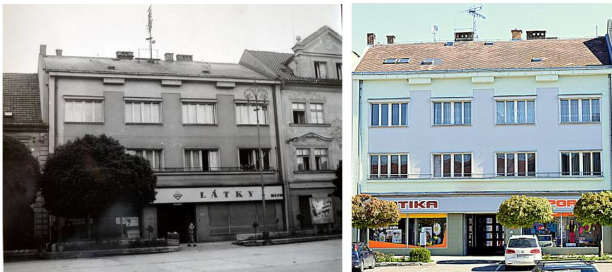
Obr. 53–54: Dobová fotografie a dnešní stav obchodního a obytného domu Dr. Vanička.
