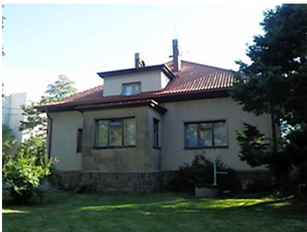
Obr. 18: Jižní průčelí vily Dimitrije Petrofa (1940).
