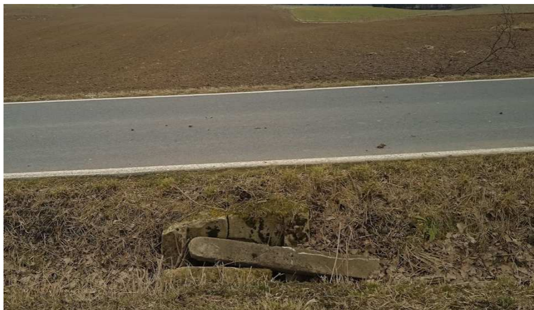
Obrázek 20 – Pozůstatek propustku/ meliorační stavby – půdní blok 9102/20
