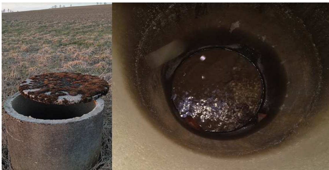
Obrázek 2 – Spojovací šachta drenážního systému (autor)
