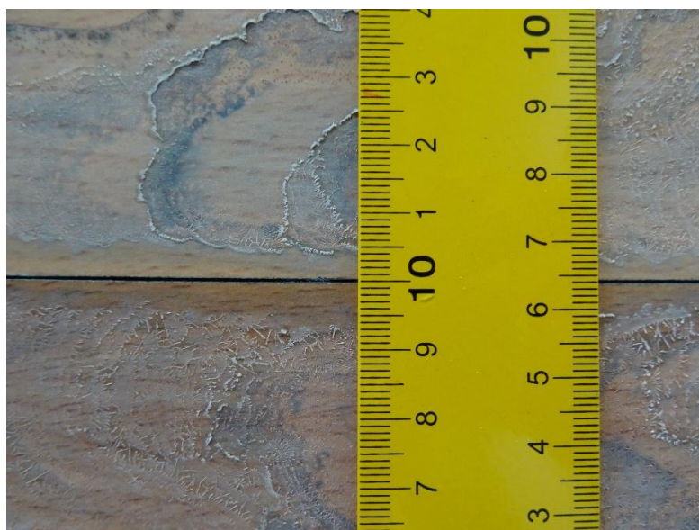
Obrázek 39 – Spáry podlahy A vlivem vlhkosti rozšířené na 0,5 milimetru
