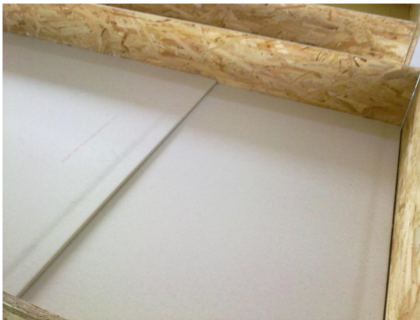
Obrázek 26 – Roznášecí vrstva ze sádrovláknitých desek
