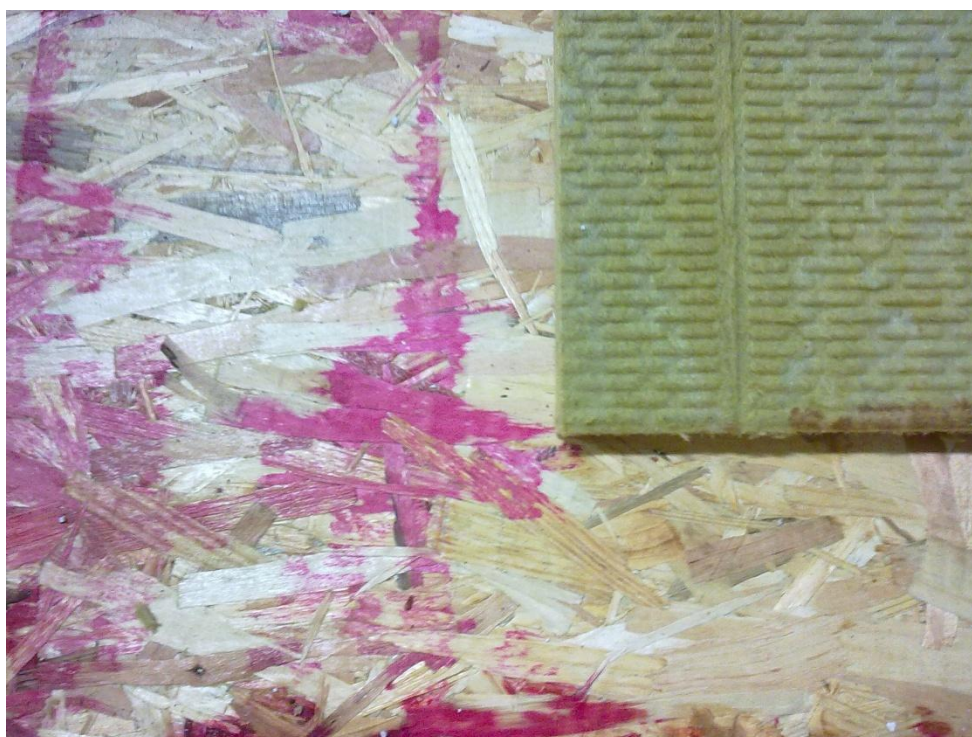
Obrázek 58 – Voda zachycená až spodní nosnou vrstvou OSB desek
