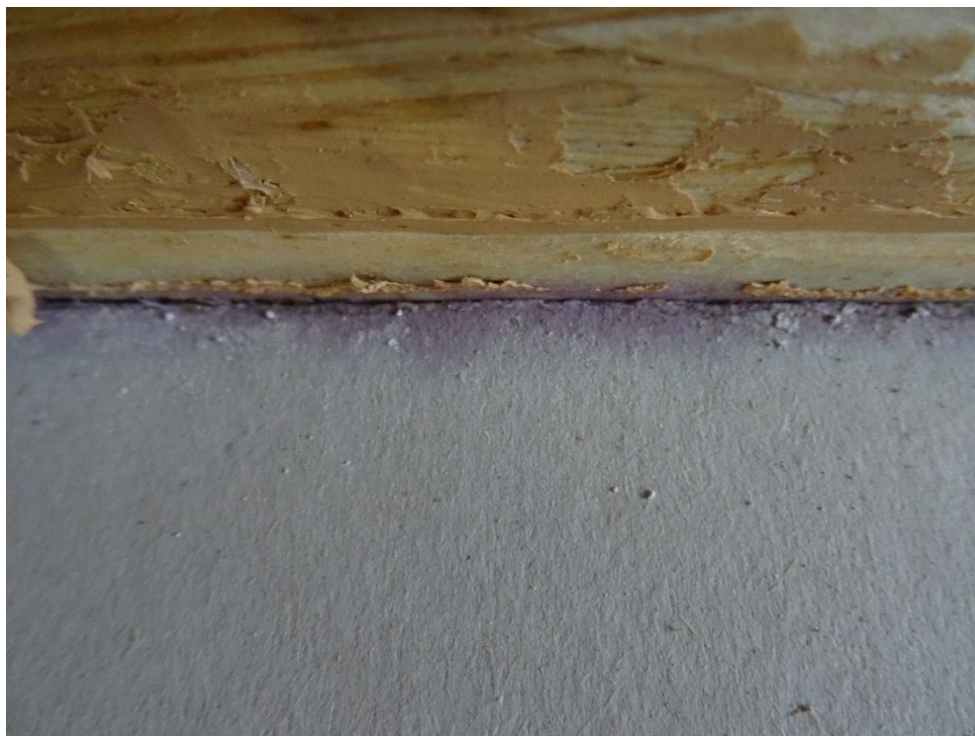
Obrázek 43 – Horní sádrovláknité desky a průnik vody po okraji OSB vany
