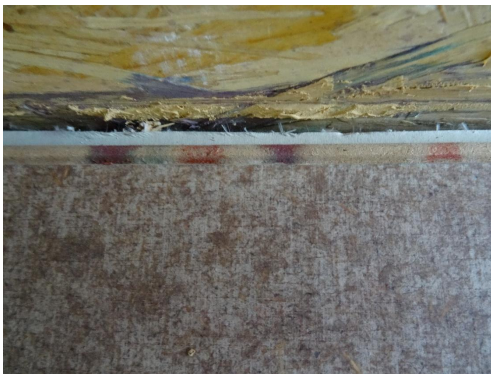
Obrázek 42 – Vrstva laminátu zespod a viditelný průnik vody po okraji OSB vany
