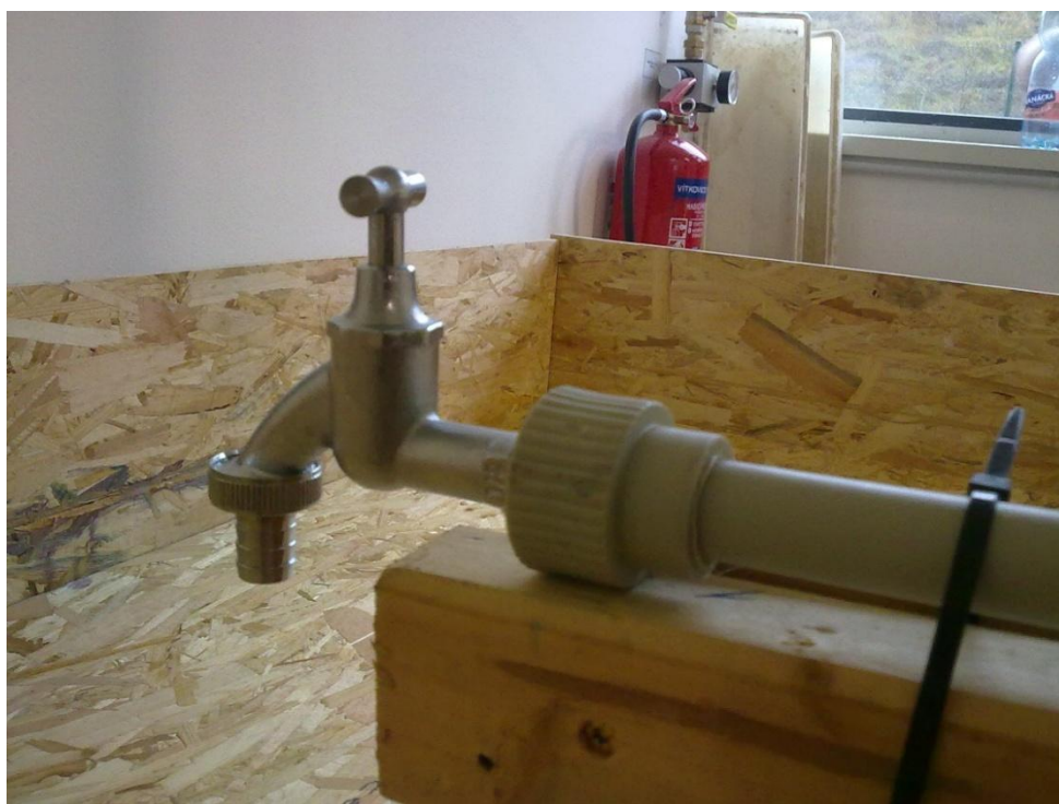
Obrázek 33 – Plastové přívodní potrubí a ocelový zahradní kohout
