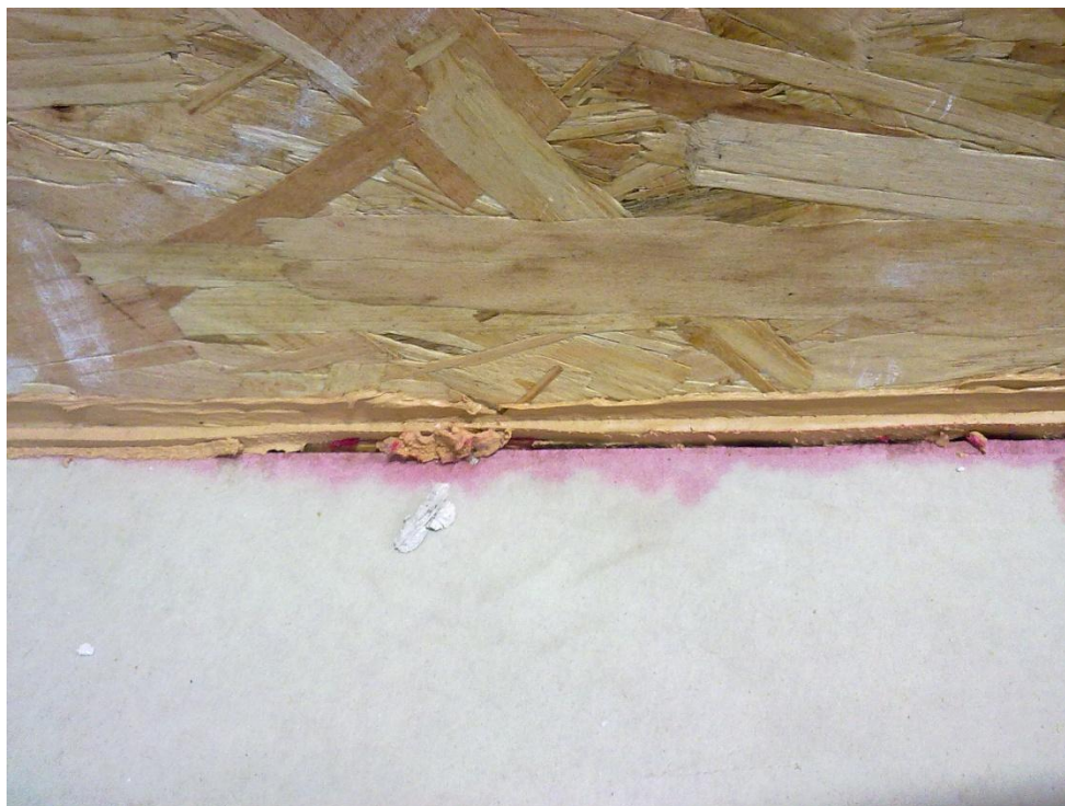
Obrázek 57 – Sádroláknité desky smáčené vodou pronikající po stěně OSB vany
