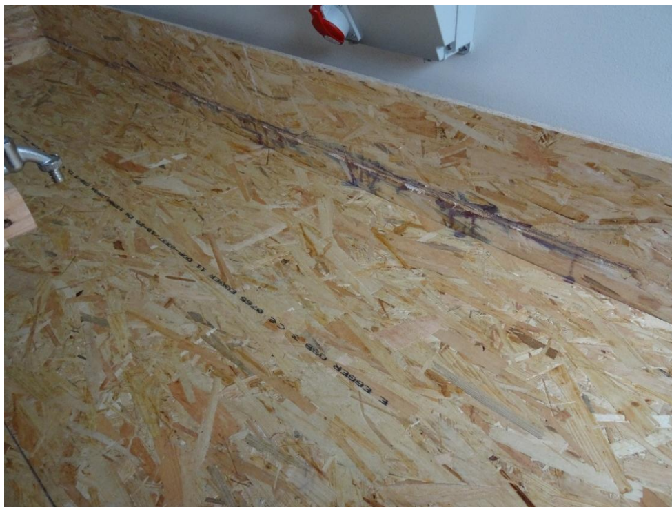
Obrázek 45 – OSB vana a viditelný průnik vody po jejím okraji až na spodní desku
