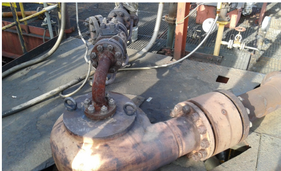
Obr.č.13 Foto původního hořáku
