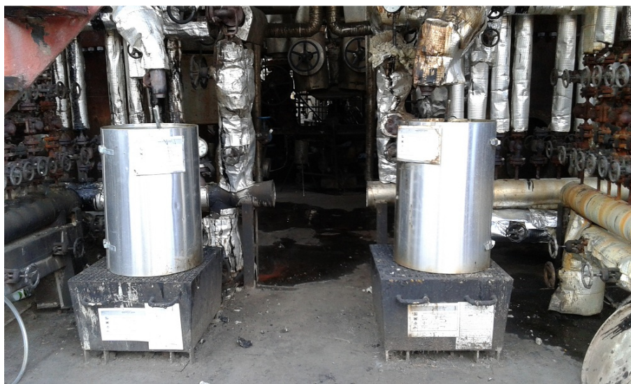
Obr.č.7 Zrekonstruované úkapové nádrže suroviny
