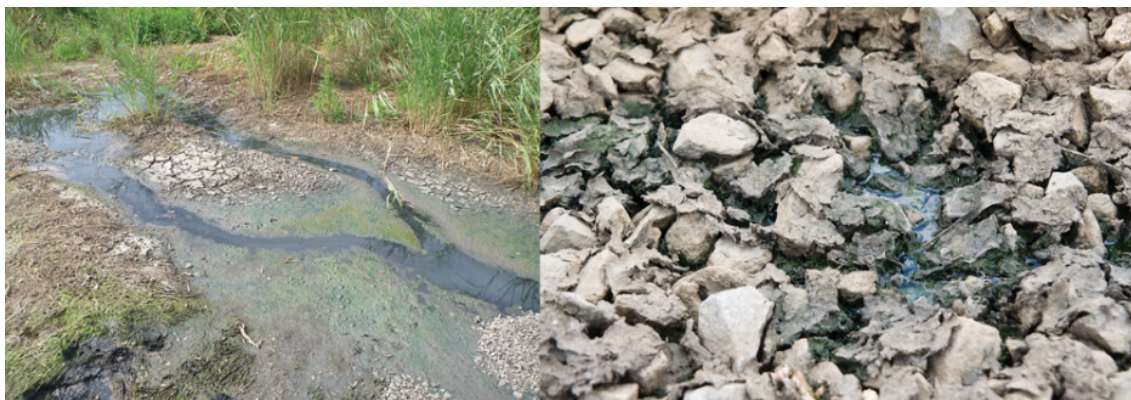
Obr. 3.7: Privilegovaná povrchová cesta (vlevo), ucpaný filtrační materiál (vpravo) [8]
