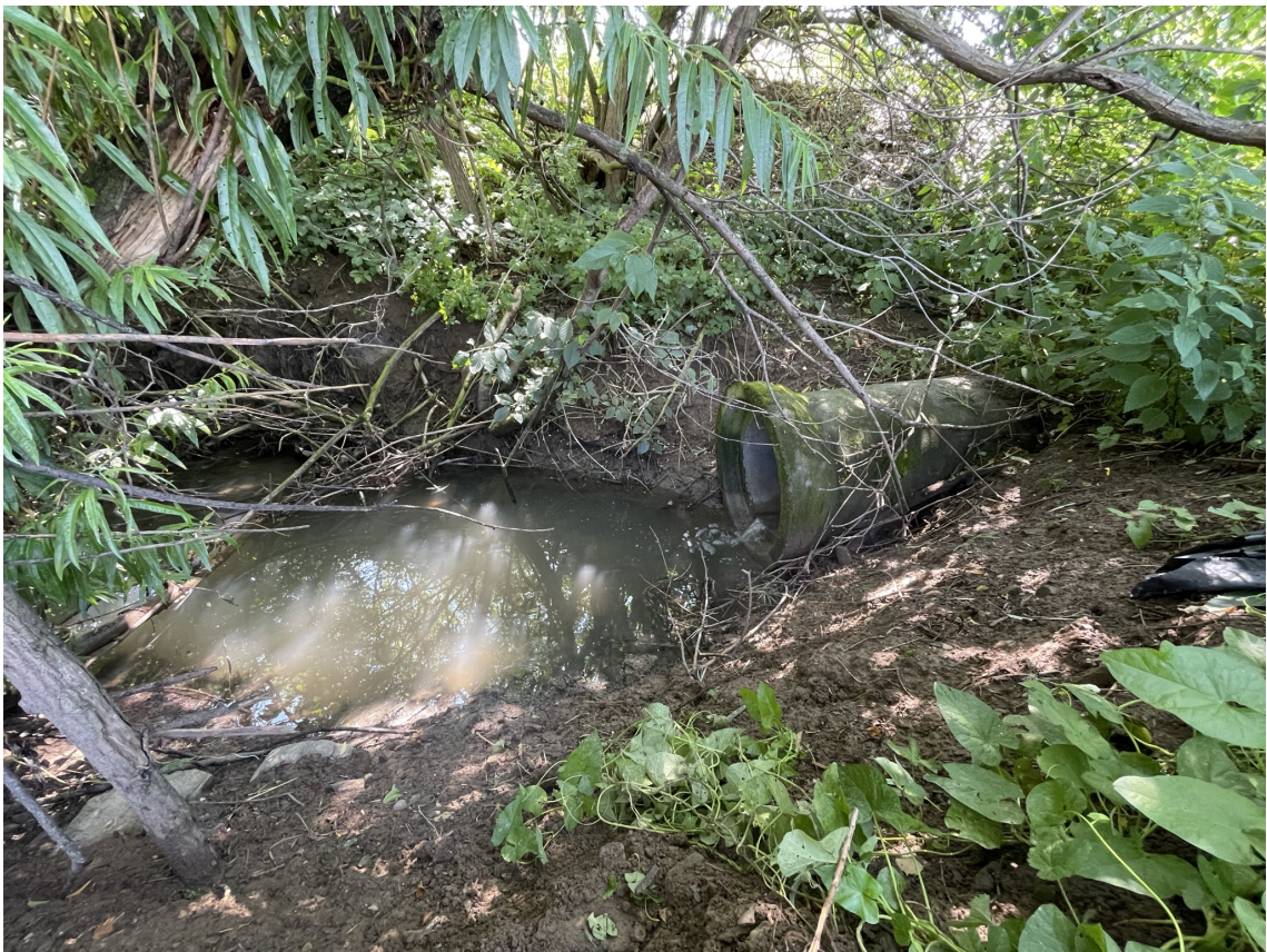
Obr. 4.3: Vyústění jednotné kanalizace do vodního toku [foto autor]
