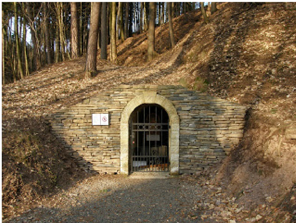
Foto č. 1: Zrekonstruovaný vstupního portál dědičné štolý Kateřina v Malých Svatoňovicích
