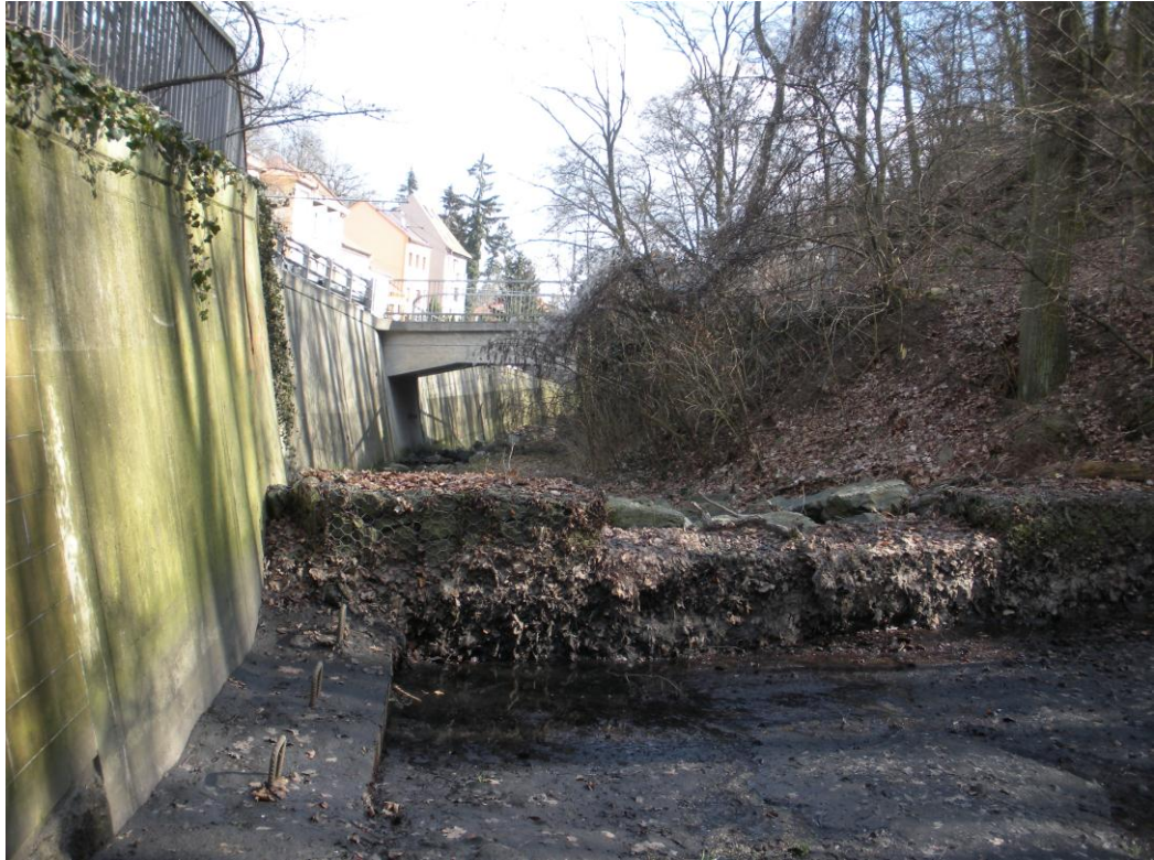
Obr. 8: Hospodářský most v 0,75930 km
