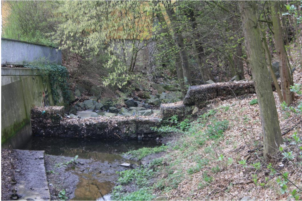
Obr. 7: Přehrážka v 0,71875 km
