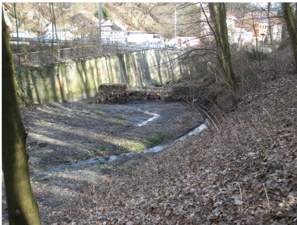
Obr. 9: Přehrážka v 0,77002 km
