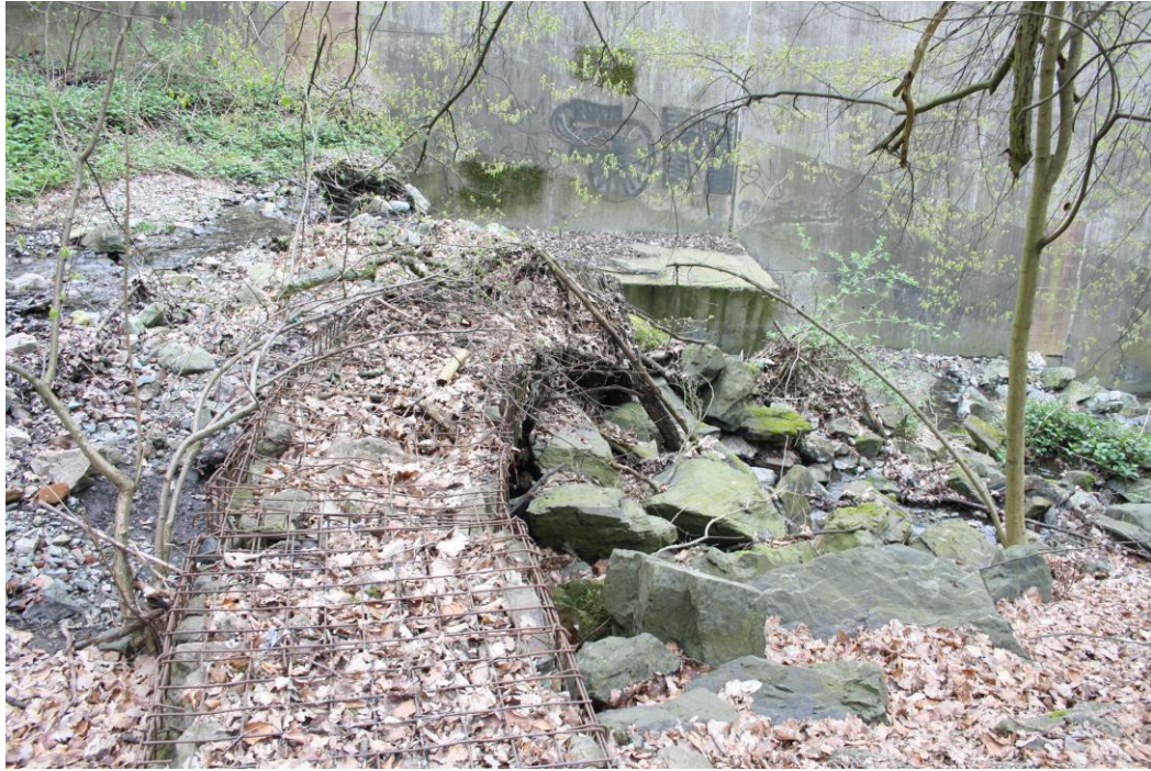
Obr. 10: Přehrážka v 0,86519 km
