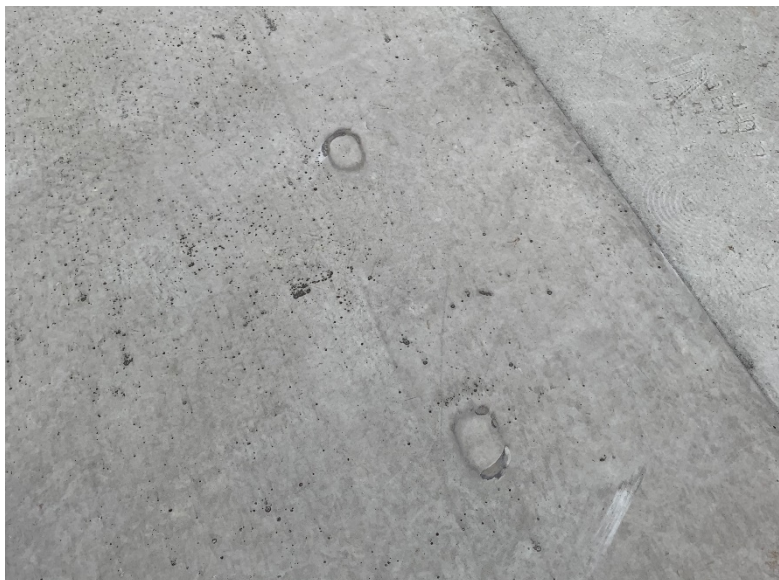
Obr. 16 Prokreslené kotvení hydroizolace [foto: autor]
