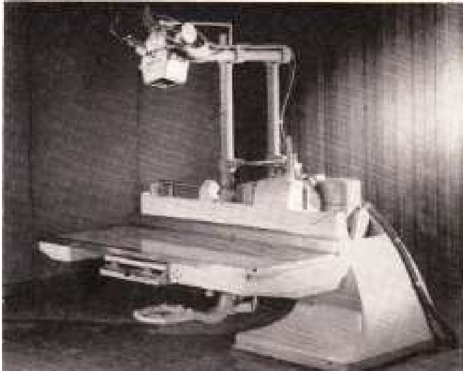
Univerzální tomografický přístroj s plošným i lineárním rozmazáním (Philips, Eindhoven)
