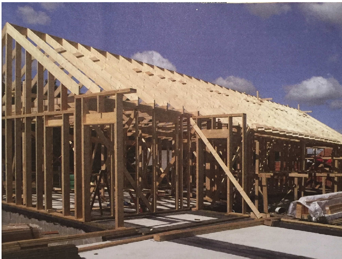
Obrázek č. 2: Kostra TBF – průběh výstavby (Růžička, 2014)
