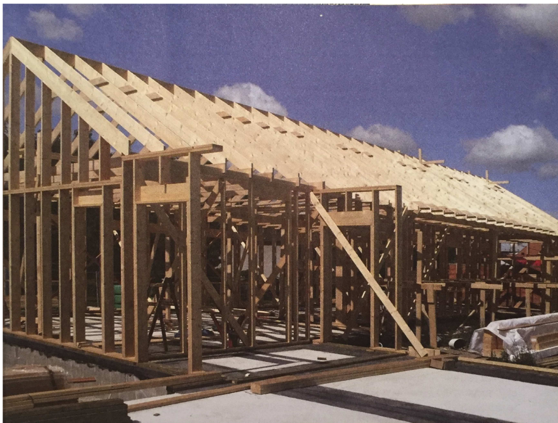
Obrázek č. 2: Kostra TBF – průběh výstavby (Růžička, 2014)
