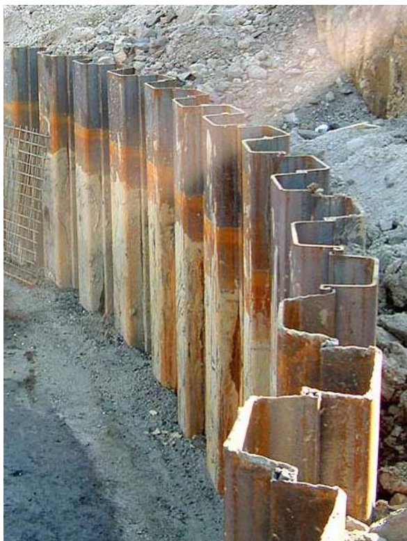
Obr. 5.11 [2.34] Štětovnicová stěna
