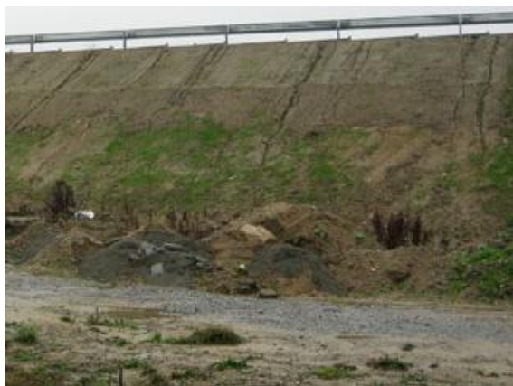
Obr. 5.6 [2.22] Typický příklad svahu bez jakékoli technické podpory
