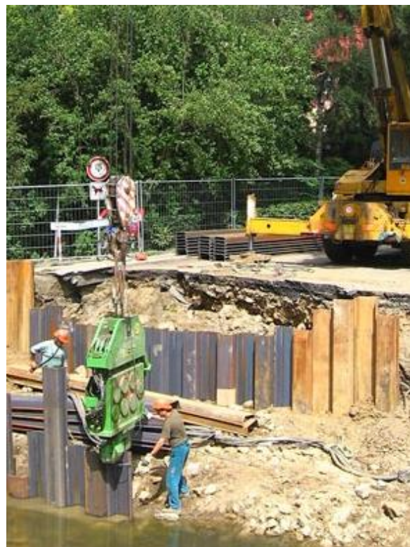
Obr. 5.12 [2.34] Provádění štětovnicové stěny v terénu
