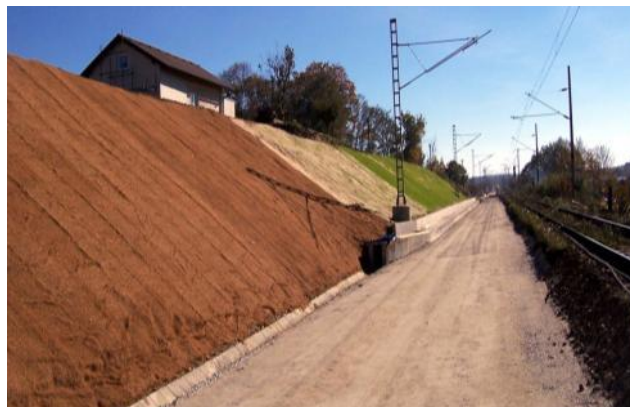
Obr. 5.7 [2.24] Opatření svahu geotextilií
