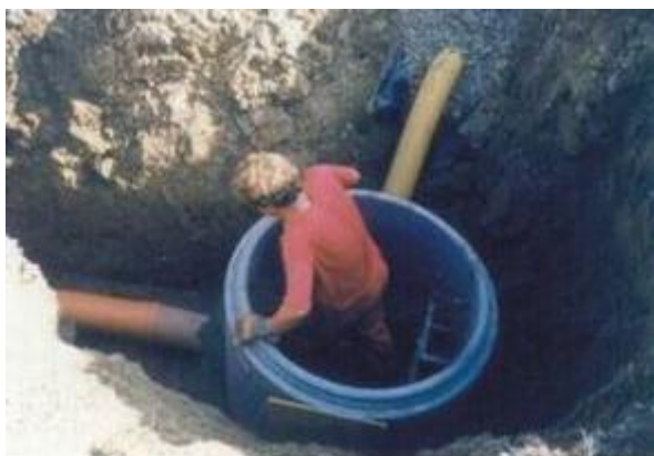
Obr. 5.2 [2.4] Vedení horizontálních odvodňovacích vrtů do studny
