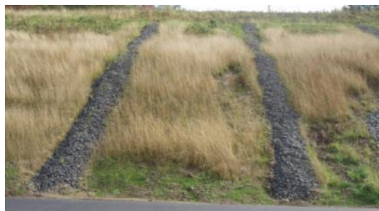
Obr. 5.4 [2.20] Provedená drenážní žebra.
