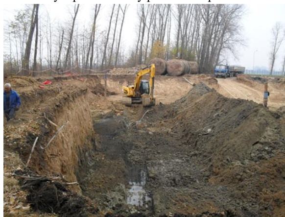
Obr. 4. Vybagrovávání kontaminované půdy
