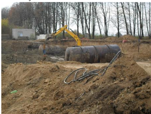
Obr. 3. Vykopané nádrže s leteckým palivem
