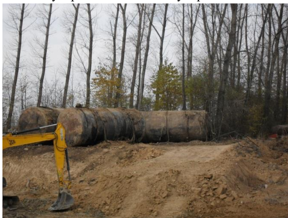
Obr. 5. Vykopané nádrže s leteckým palivem
