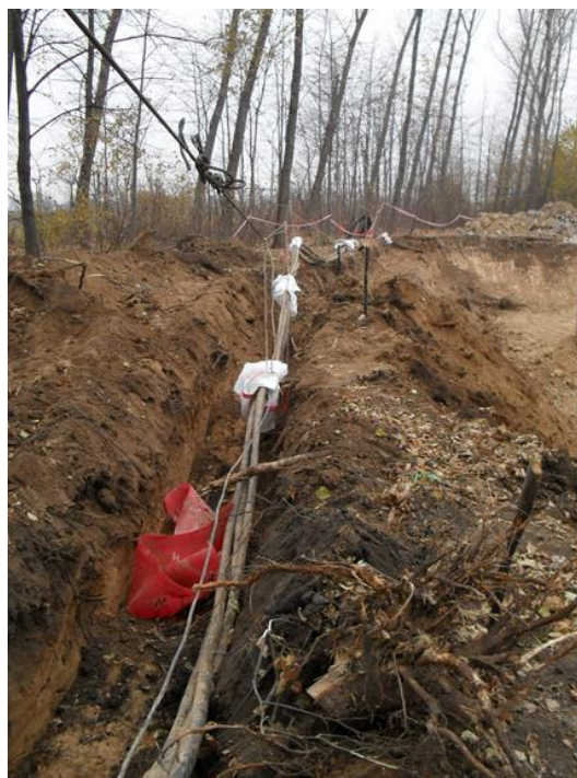
Obr. 2. Vykopané rozvody pro letecké palivo
