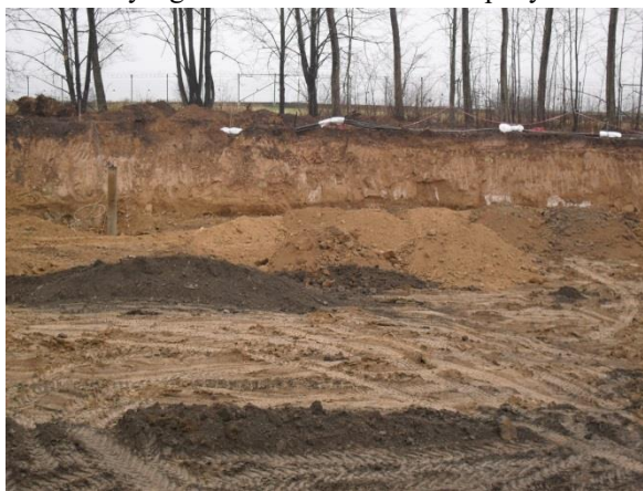
Obr. 6. Vybagrovaná kontaminovaná půda
