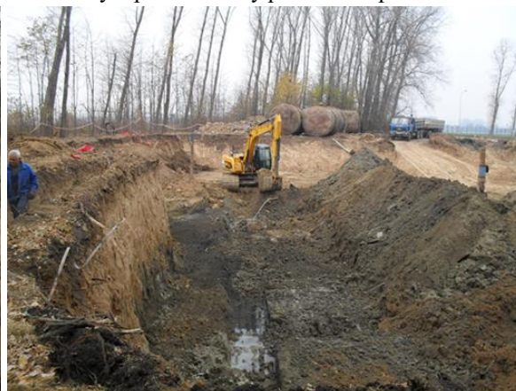
Obr. 4. Vybagrovávání kontaminované půdy
