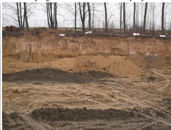
Obr. 6. Vybagrovaná kontaminovaná půda
