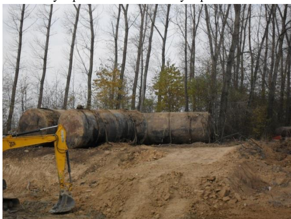
Obr. 5. Vykopané nádrže s leteckým palivem
