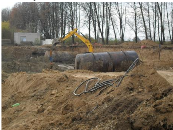
Obr. 3. Vykopané nádrže s leteckým palivem
