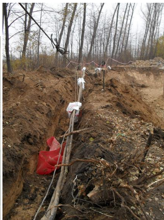
Obr. 2. Vykopané rozvody pro letecké palivo
