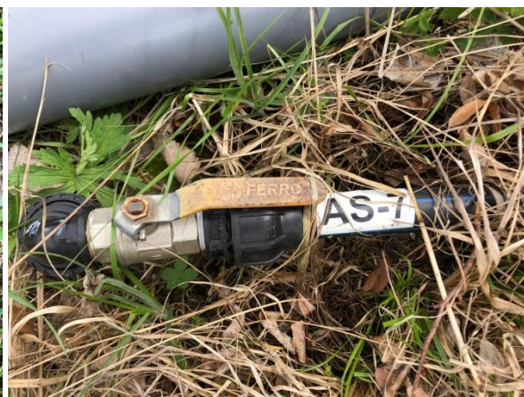
Obr. 8. Aplikační potrubí pro bakterie
