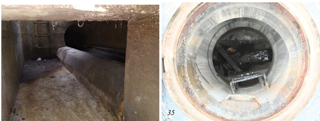
Obrázek 34, 35: OK s přepadem jednostranným bočním s přímou hranou ( vlastní foto, 2021 ); OK s přepadem přímým se šikmou hranou ( vlastní foto, 2021 )
