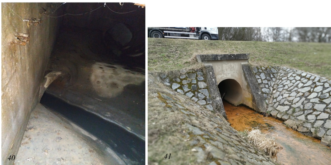
Obrázek 40, 41: Odlehčovací komora OK27, přepadová hrana ( vlastní foto, 2021 ); Vyústění z OK27, ( vlastní foto, 2021 )
