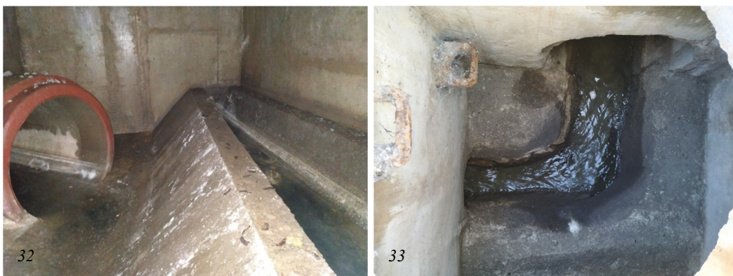
Obrázek 32, 33: OK s přepadem jednostranným bočním se šikmou hranou ( vlastní foto 15.2.2021 ); OK s přepadem přímým s kolmou hranou ( vlastní foto, 2021 )
