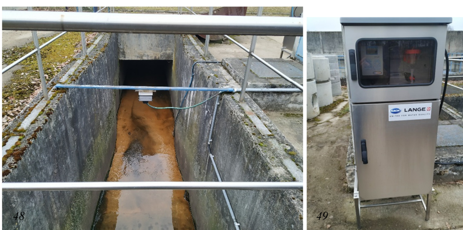
Obrázek 48, 49: Měrné místo na odtoku z odlehčení v areálu ČOV, (vlastní foto, 2021); Odběrné zařízení na odtoku z odlehčení v areálu ČOV, (vlastní foto, 2021)
