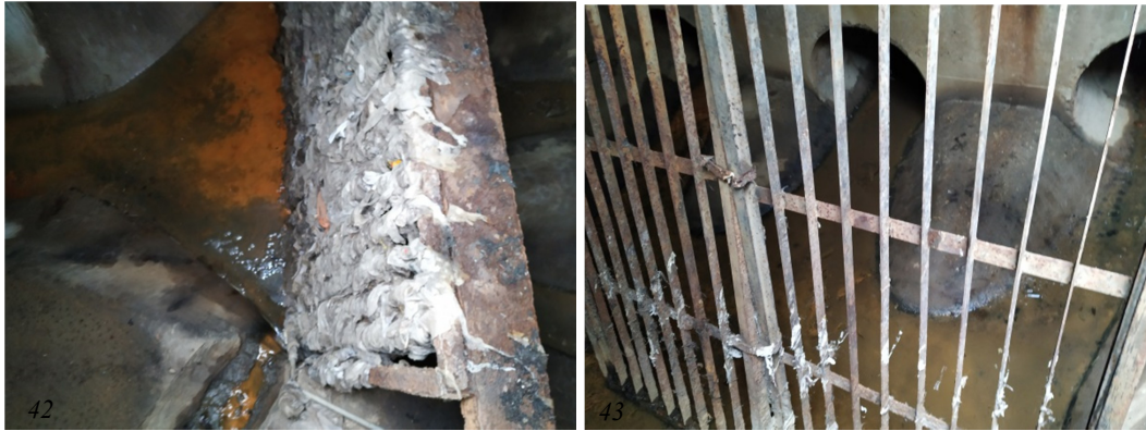
Obrázek 42, 43: Zanesené česle po dešti v OK 27, (vlastní foto, 2021); Vyčištěné česle v OK 27, (vlastní foto, 2021)
