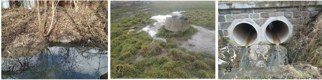
Obrázek 51, 52, 53 : výust' z OK 54 (U Pily); výust' z OK 63 (Zavadilka); výust' z OK 55 (Novohradská), (vlastní foto, 2021)
