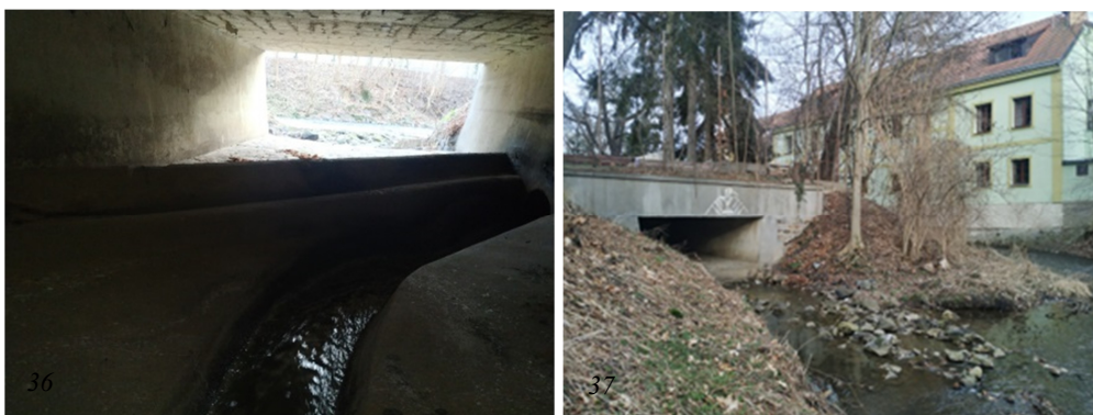
Obrázek 36, 37: Odlehčovací komora OK2 , přepadová hrana (vlastní foto, 2021); Vyústění z OK2, (vlastní foto, 2021)
