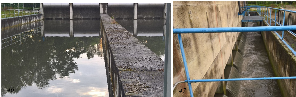
Obrázek 46, 47: Dešťové nádrže na odlehčení v areálu ČOV, (vlastní foto, 2018); Odtok z dešťových nádrží na odlehčení v areálu ČOV, (vlastní foto, 2018)
