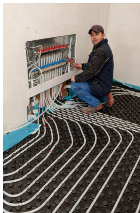
Obrázek č. 6: Ukázka potrubí a rozdělovače podlahového vytápění
